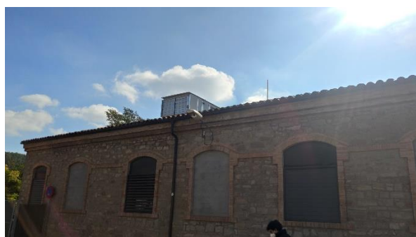
Fig. 5 Vista general coberta des d'abaix
