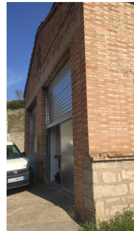
Fig. 11 Recorregut pas de cables accés planta 9
