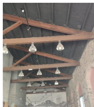
Fig. 4 Vista interior de la coberta
