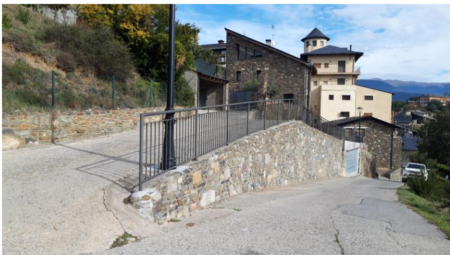
FOTO 9: Vista de barana tipus - MONTFERRER
