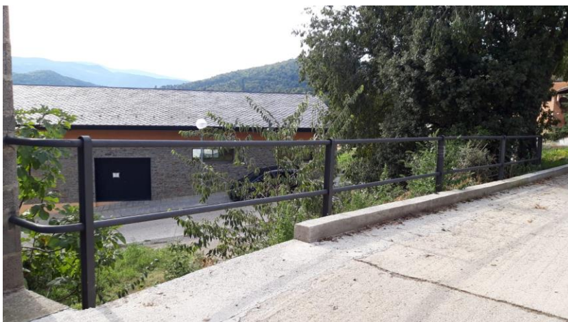
FOTO 2: Vista de barana existent - ARAVELL
