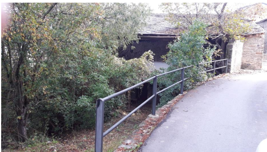
FOTO 7: Vista de barana existent - MONTFERRER
