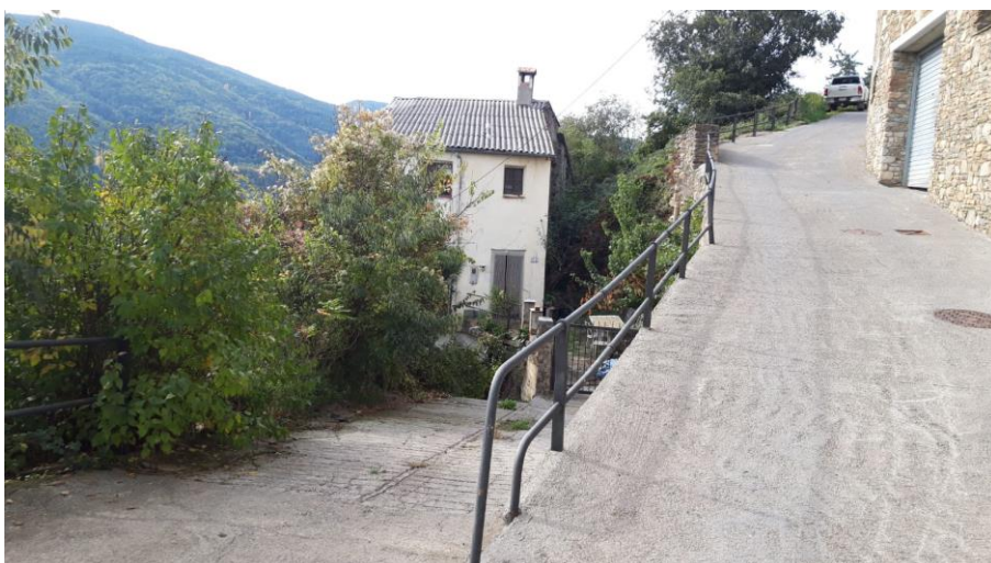
FOTO 8: Vista de barana existent - MONTFERRER
