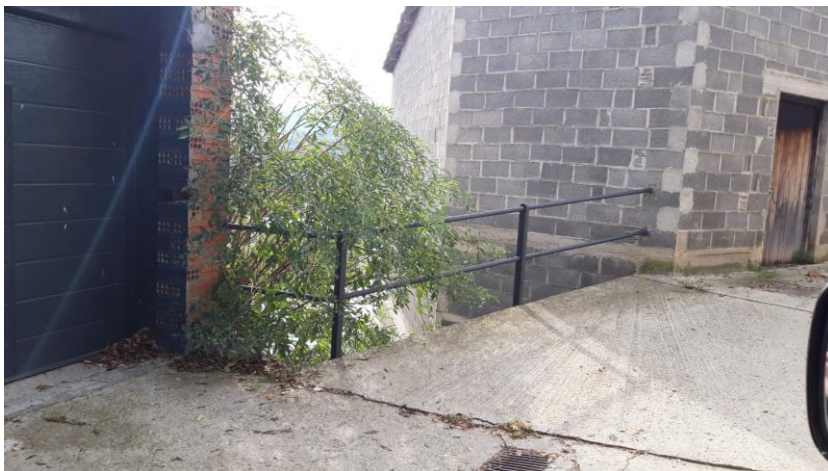
FOTO 1: Vista de barana existent - ARAVELL
