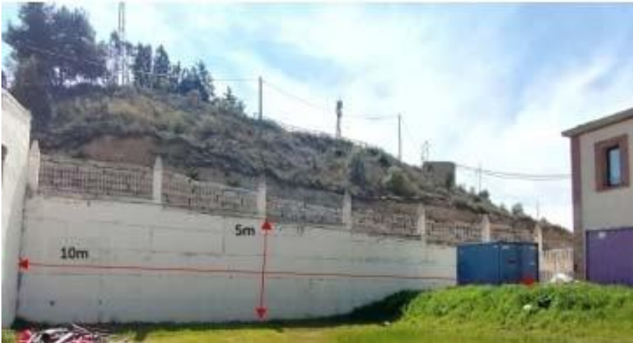
Mur de contenció
