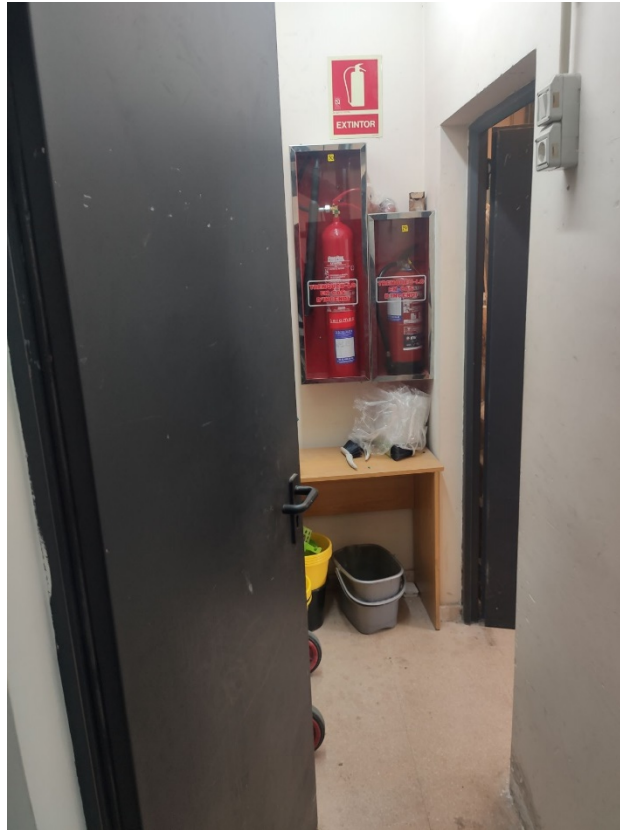
Vestíbul previ, accés des de interior de l'edifici
