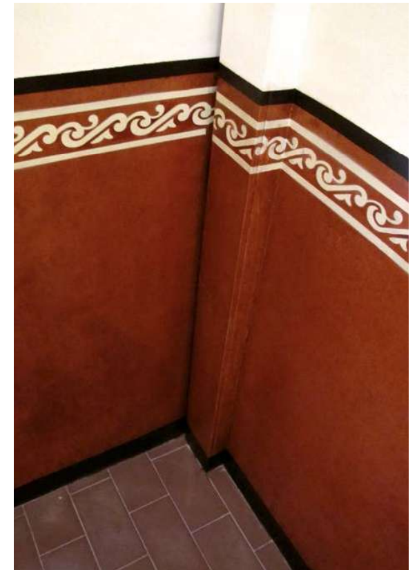
Rehabilitación de viviendas
