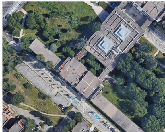
Edifici Facultat de Dret
