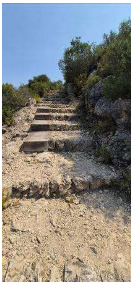
reparació puntual amb graons de formigó
