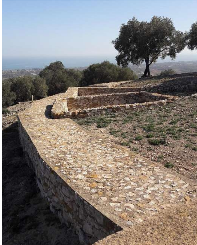
Format emprat en la consolidació i restauració inicial de la muralla del poblat. S'hi pot observar també la forma impròpia com l'àmbit A67 s'hi relaciona amb la muralla en aquesta consolidació
