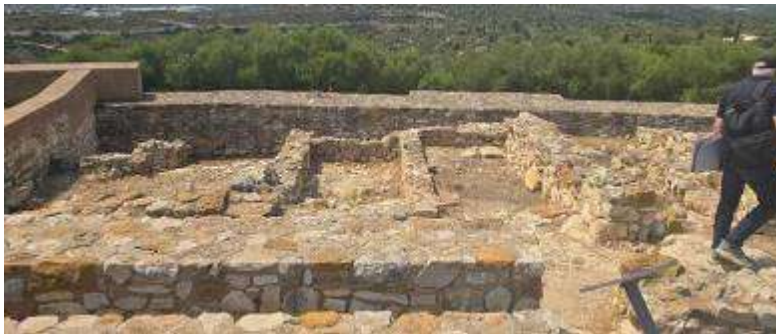
ÀMBIT 4 - Consolidació i estabilització de les estructures muraries del sector sud-oest del jaciment.
