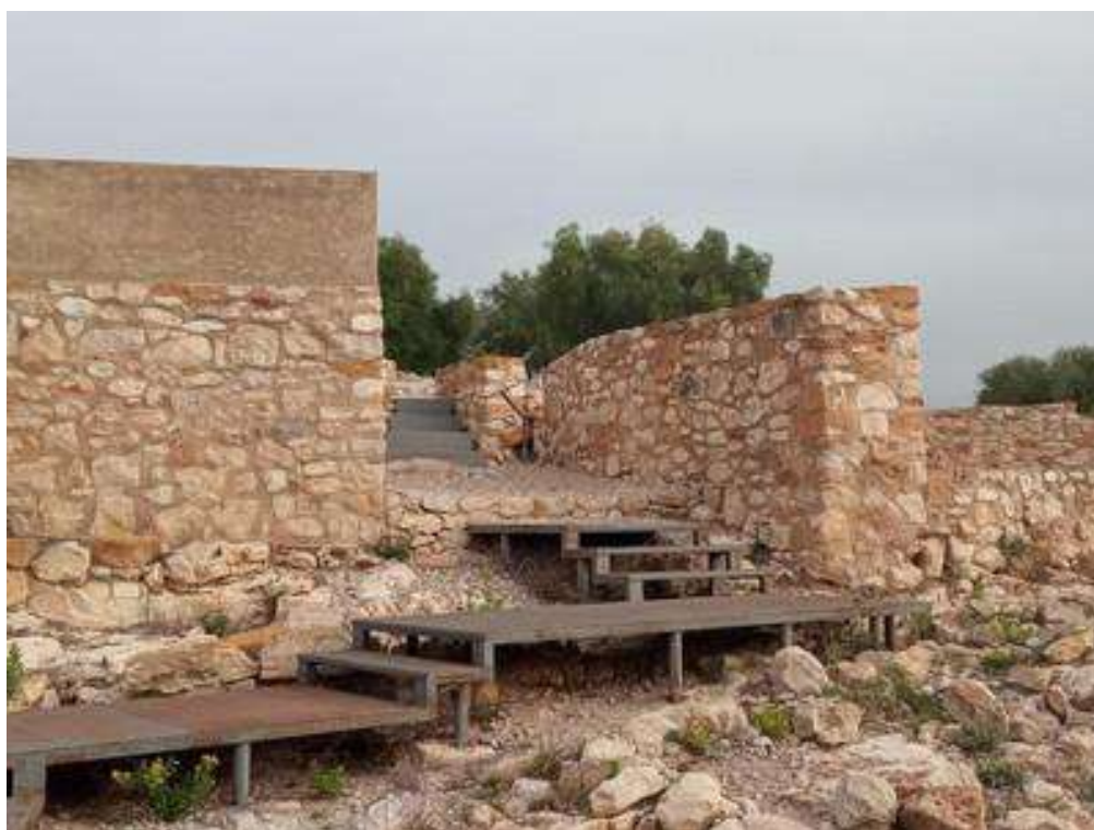
Entrada oficial del poblat, al final del camí de lloses de formigó. S'hi pot observar l'estructura metàl·lica esgraonada que salva el desnivell entre el final del camí i la part més alta del turó.
