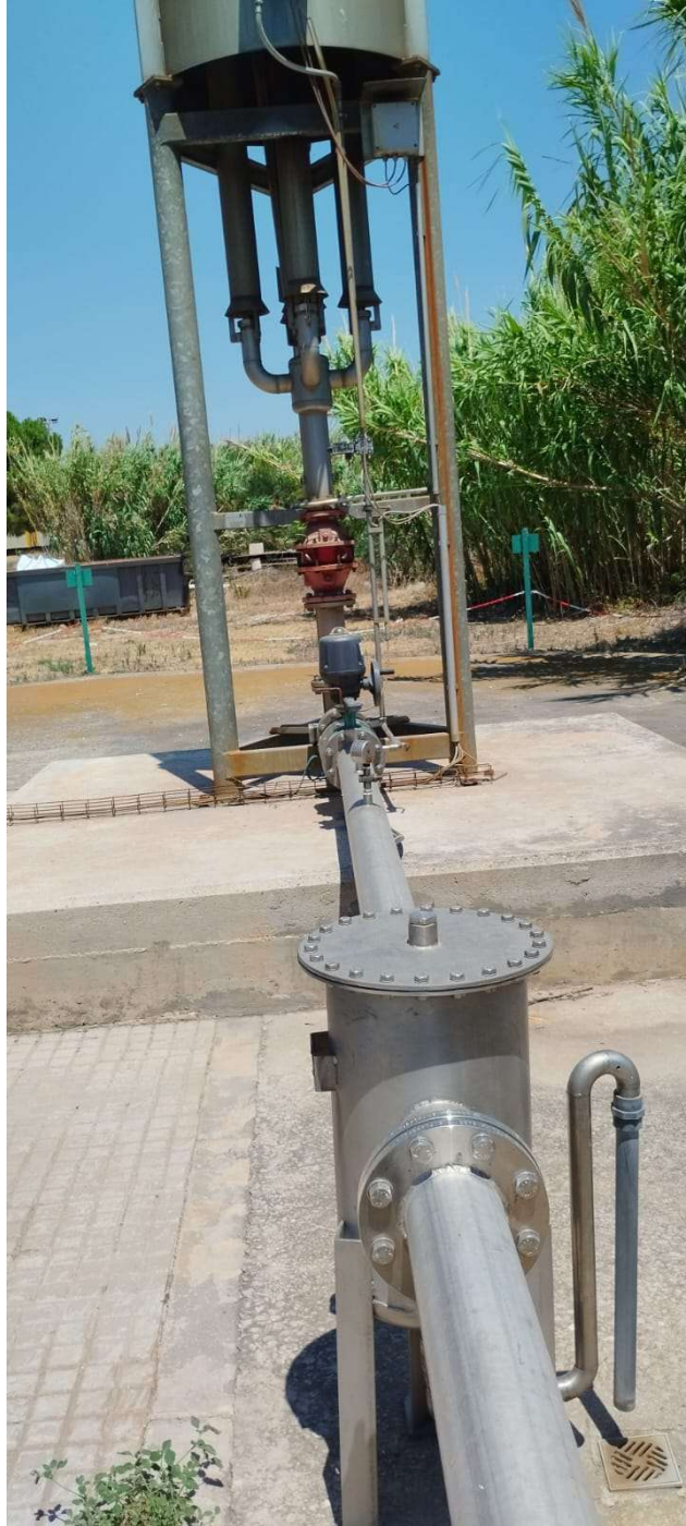
Il·lustració 9 Filtre de condensats previ a la torxa Hofstetter
