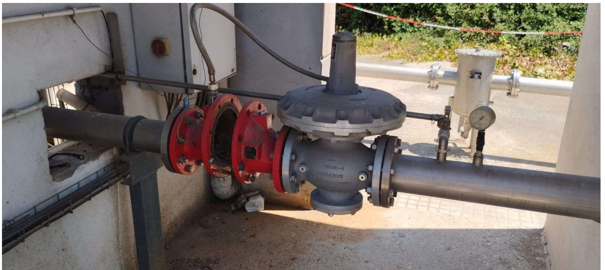
Il·lustració 5 Válvula pressió i apaga focs torxa Groth
