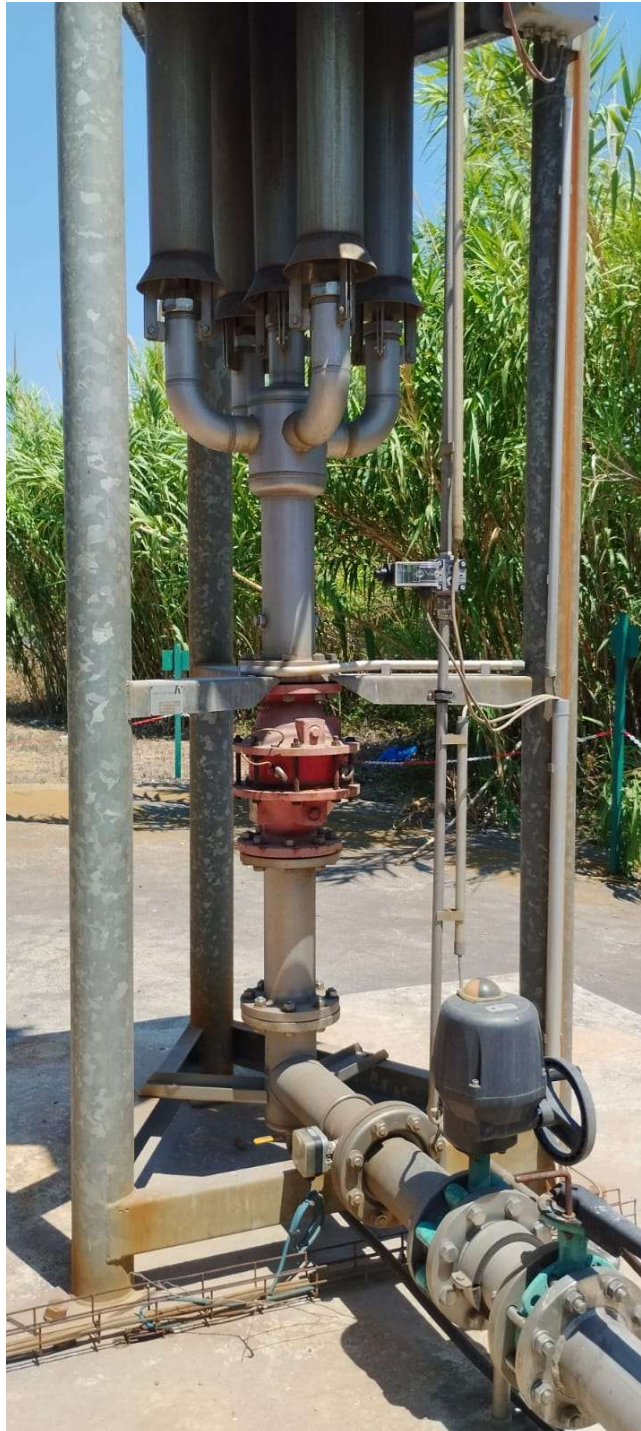
Il·lustració 8 Elements torxa Hofstetter
