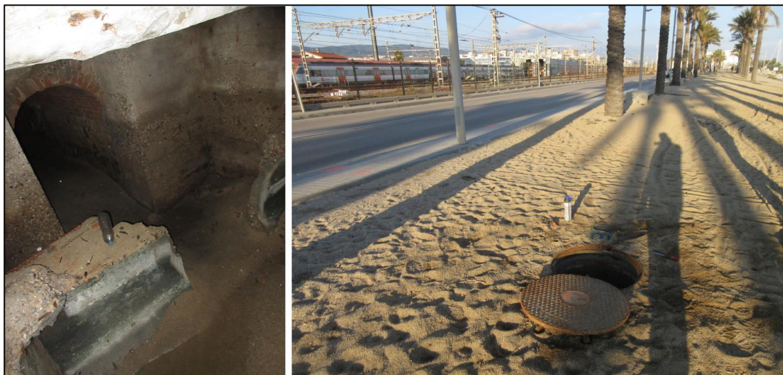
Figura 5: Galeria perpendicular a les vies i tub de Ø1000
