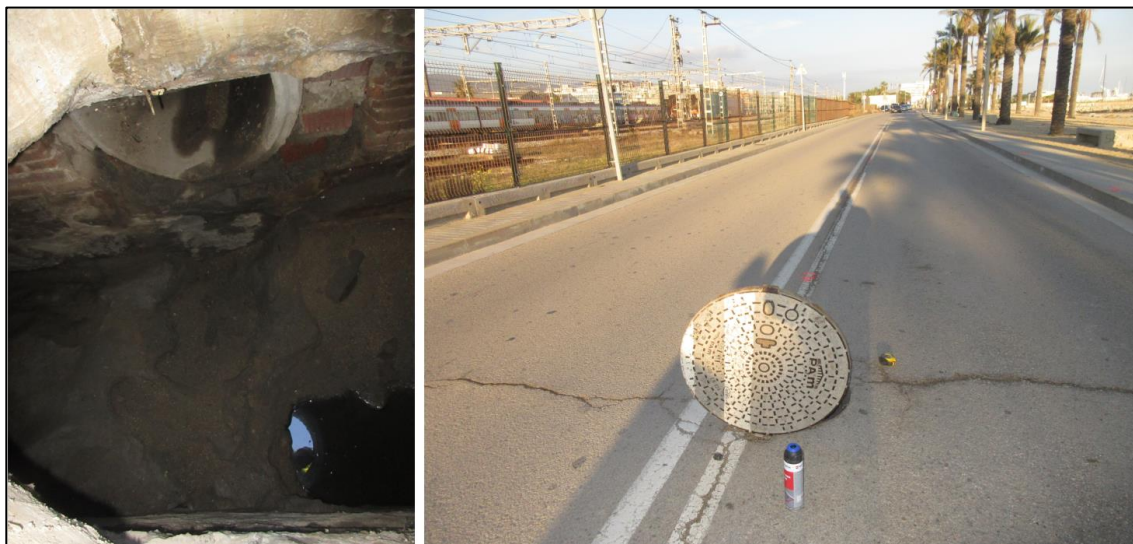
Figura 6: Tub de Ø400 i galeria perpendicular
