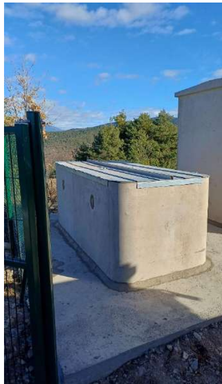
Arqueta en la parte superior del pozo
