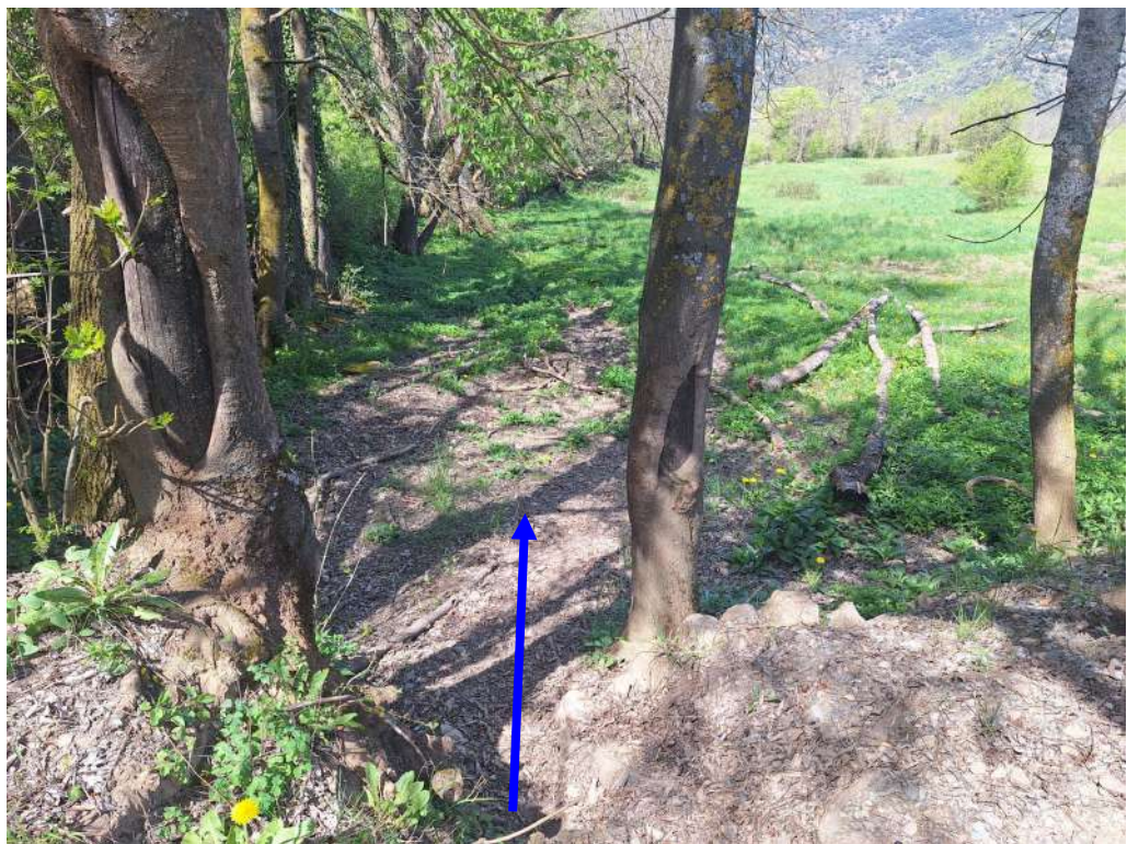
Foto 6: pK 0+072 desnivel de 2m. Válvula de ventosa. Paso de parcela 560 a parcela 561. Vista sentido aguas abajo.
