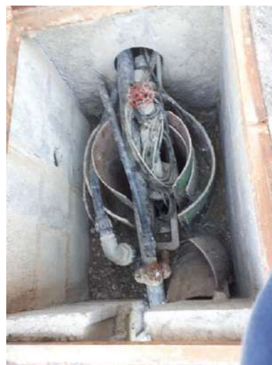
Interior arqueta pozo
