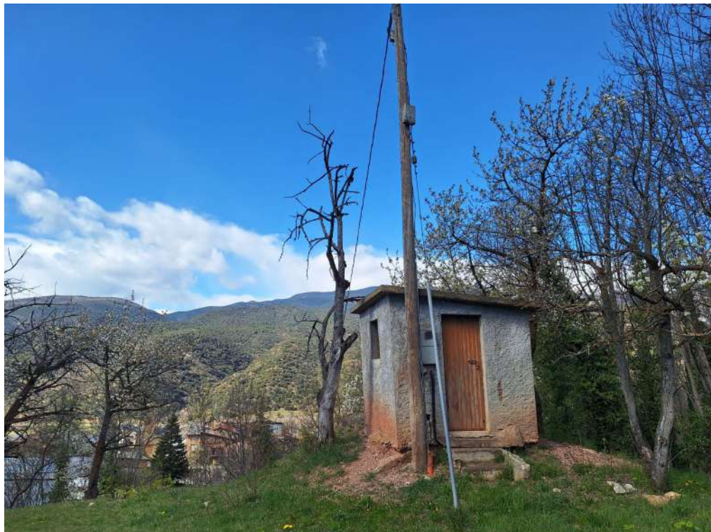
Foto 28: Caseta en la parte superior del depósito viejo y línea eléctrica aérea existente.
