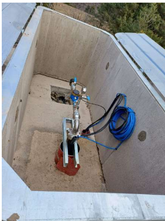
Arqueta en la parte superior del pozo
