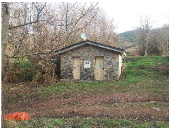
Edificio junto al depósito.
