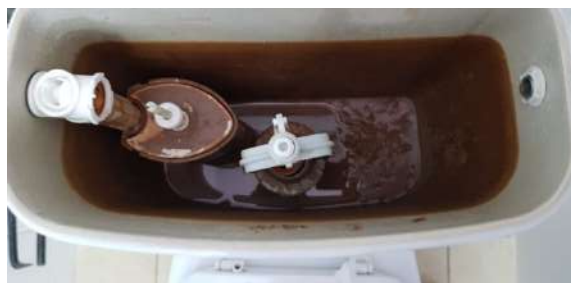
Sanitarios campo de fútbol (octubre 2023)
