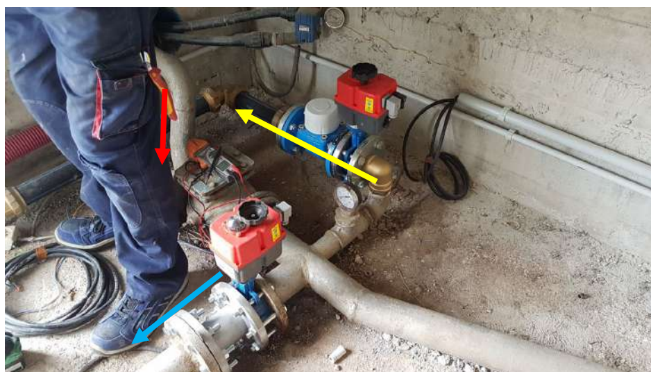
Instalación de válvulas motorizadas y conexión a las instalaciones del campo de fútbol.
