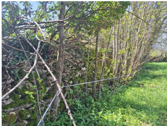
Foto: Vista del muro de piedra seca de 2,5 m que separa las parcelas 526 y 524 del polígono 1
