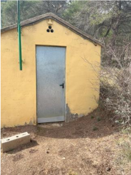
Imatge 14. Dipòsit principal d'Ulldemolins
