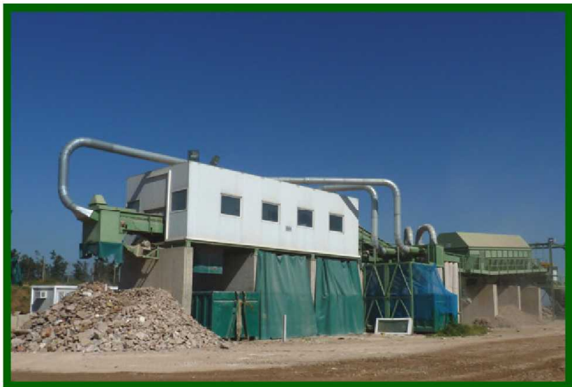
CENTRAL DE RECICLAJE DE RCD’S DE MONTAPRE (Sant Julia de Ramis, Girona)
