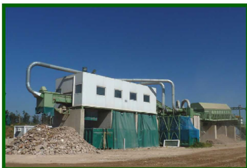
CENTRAL DE RECICLAJE DE RCD'S DE MONTAPRE (Sant Julià de Ramis, Girona)
