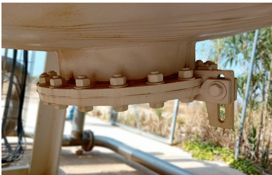
Figura 4. Detall de la boca d'accés inferior.
