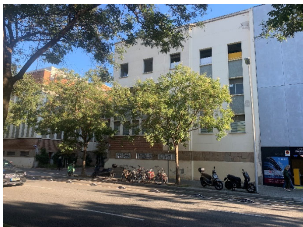
Façana C. Bilbao (Sud)
