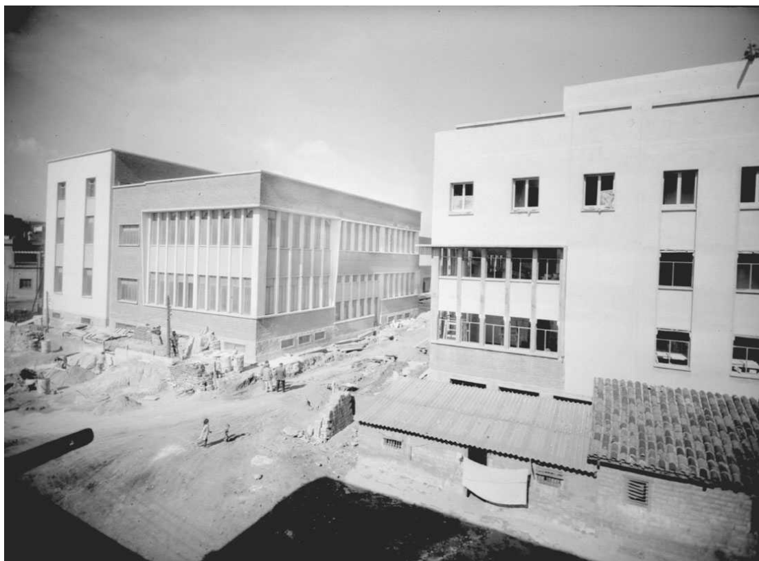
Construcció del conjunt de l'antiga fàbrica Frigo, amb l'edifici B en primer terme a la dreta, 1959-1960
