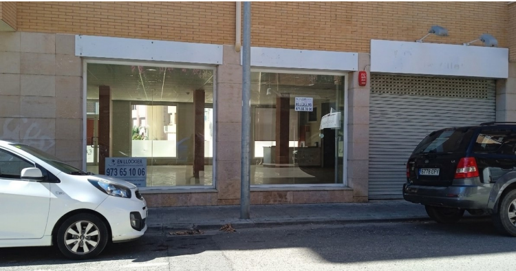
Façana carrer Sant Jordi
