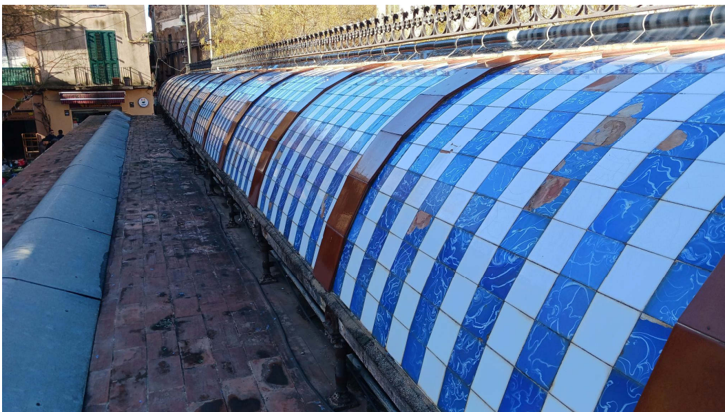
Vista coberta costat mar
