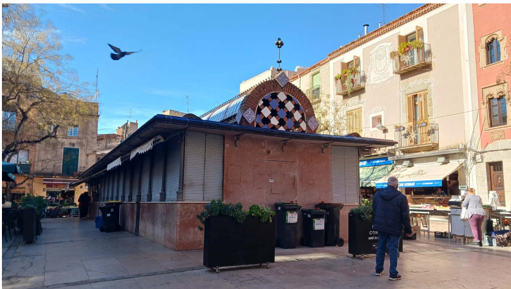
Vista general façana lateral nord
