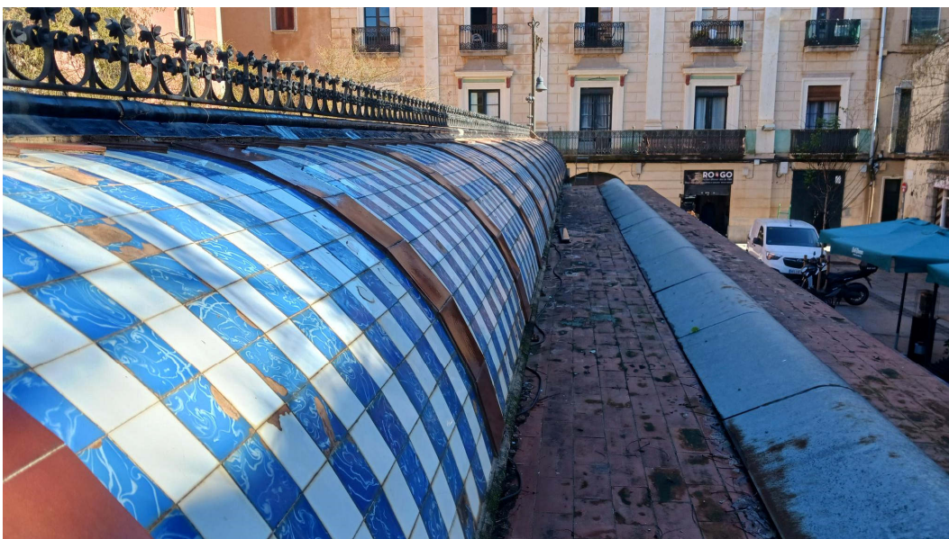
Vista coberta costat muntanya
