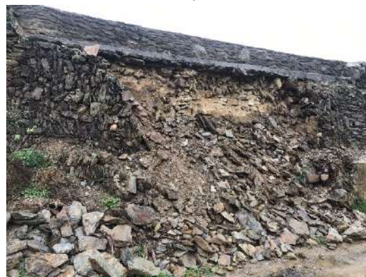
Imatge 05. Estat actual del tram de mur 1. Mur de
