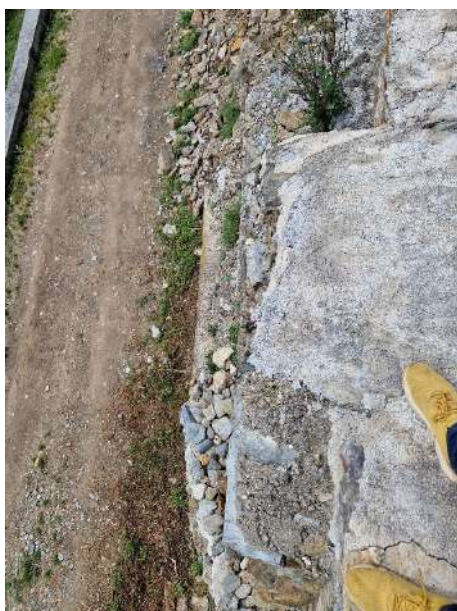
Imatge 02. Estat actual del tram de mur 1 del camí de Benavarre. Vist des del muret perimetral superior.
