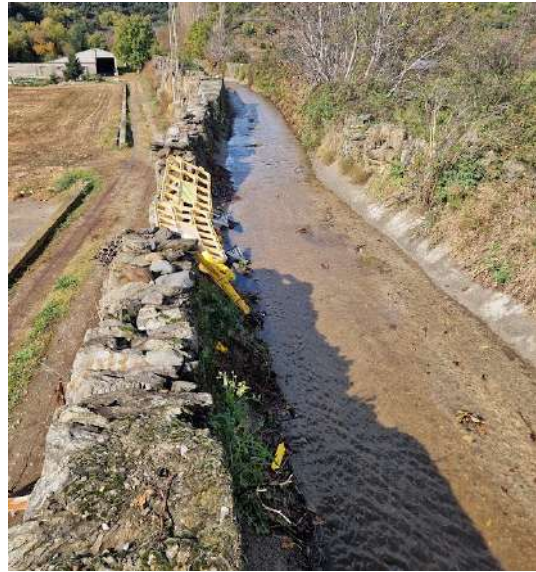
Imatge 07. Estat actual del tram de mur 2.
