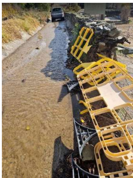
Imatge 05. Estat actual del tram de mur 2.
