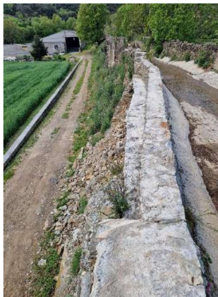
Imatge 02. Estat actual del tram de mur 1. Muret perimetral camí superior.
