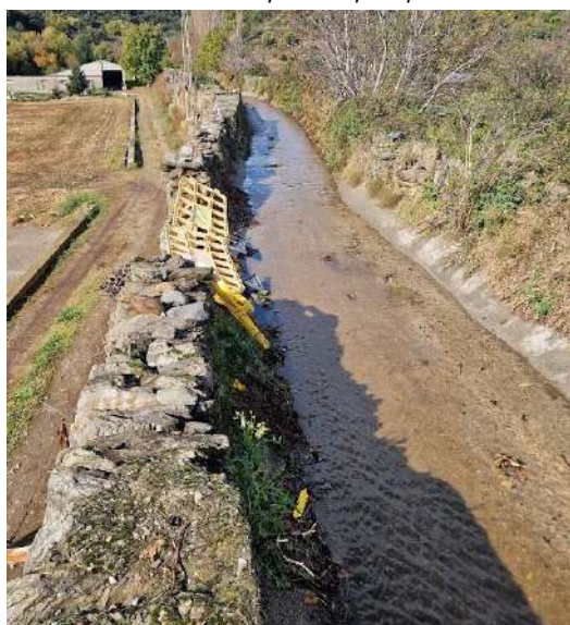
Imatge 06. Estat actual del tram de mur 2.
