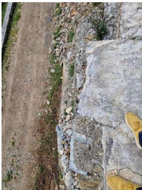
Imatge 01. Estat actual del tram de mur 1 del camí de Benavarre. Vist des del muret perimetral superior.
