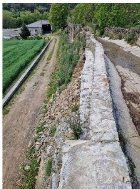
Imatge 03. Estat actual del tram de mur 1. Muret perimetral camí superior.
