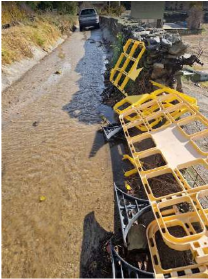
Imatge 06. Estat actual del tram de mur 2.
