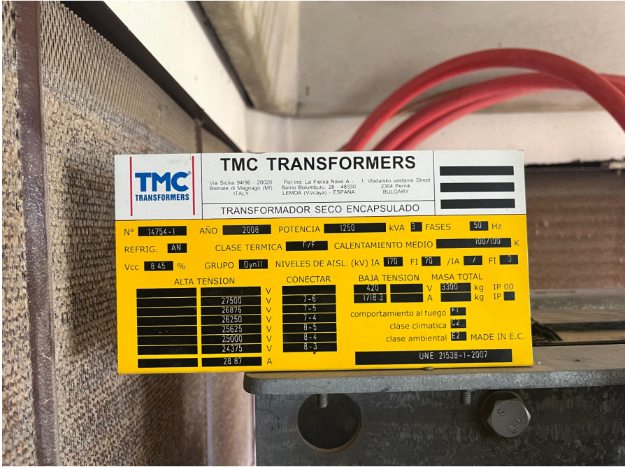
Fotografia de la placa de característiques del transformador afectat.
