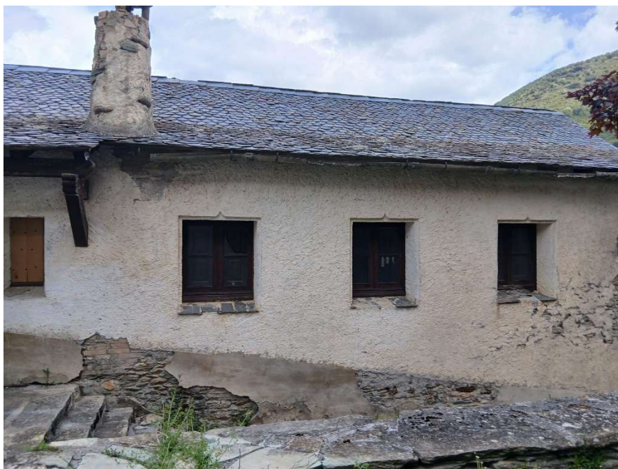
Façana lateral accès 2
