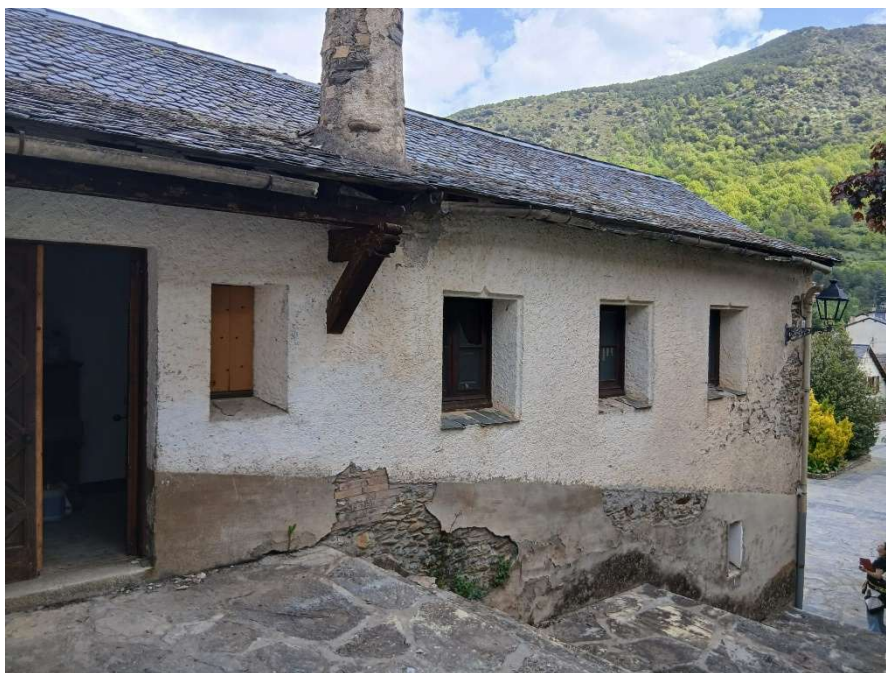
Façana lateral accès 3
