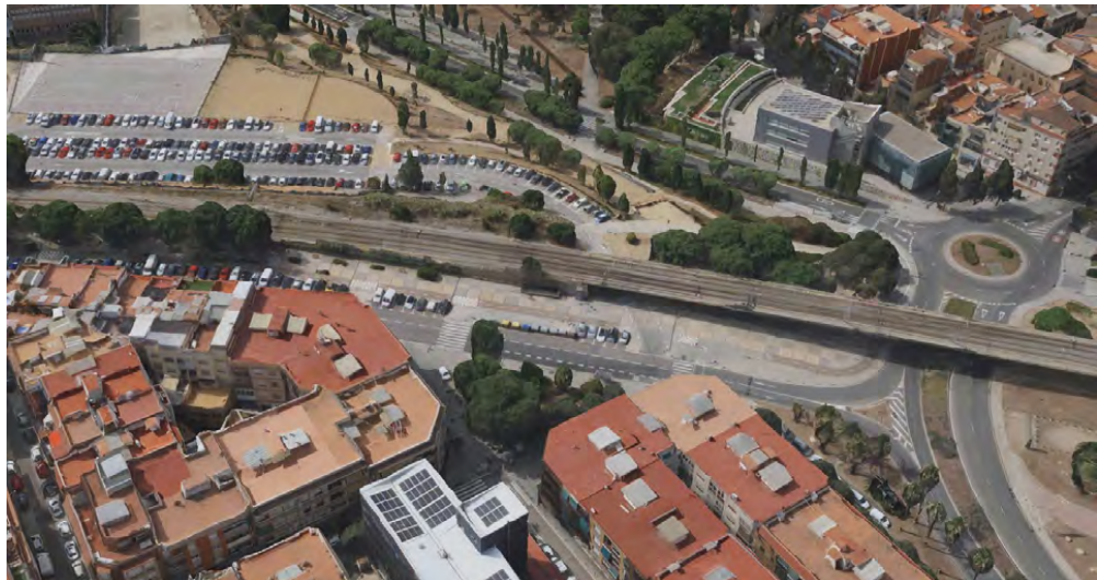
Vistes aèries generals de l'avinguda Salvador Allende.
