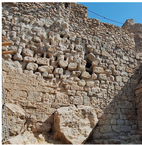
Fig. 1 y 2. Restos de estructuras históricas aparecidas en las excavaciones realizadas recientemente en el bastión de mediodía que requieren una consolidación lo más pronta posible. Y estado de degradación y pérdidas volumétricas que presenta el muro de cerramiento del recinto superior adyacente una vez eliminado el relleno del bastión que se le adosaba.
