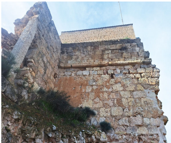
Fig. 4 y 5. Zonas de la parte superior incompleta de la torre del tesoro, actualmente apeadas provisionalmente con pilares de fábrica de ladrillo; y detalle de degradación con pérdidas volumétricas importantes existentes actualmente, en la base de muros interiores de la misma torre.
