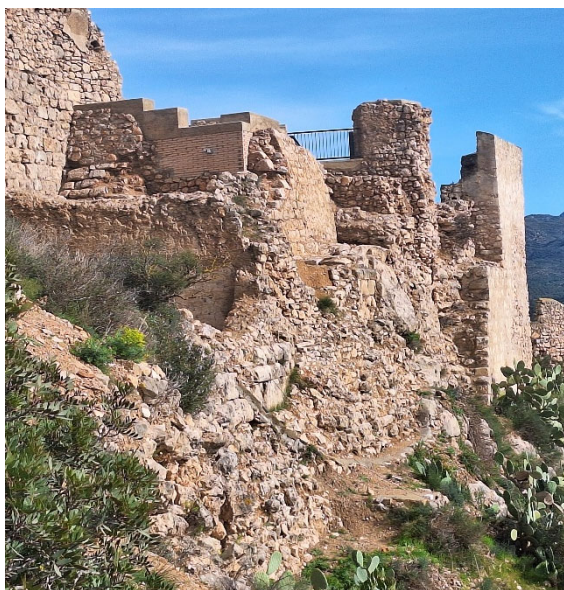
Fig. 1 y 2. Restos de estructuras históricas aparecidas en las excavaciones realizadas recientemente en el bastión de mediodía que requieren una consolidación lo más pronta posible. Y estado de degradación y pérdidas volumétricas que presenta el muro de cerramiento del recinto superior adyacente una vez eliminado el relleno del bastión que se le adosaba.
