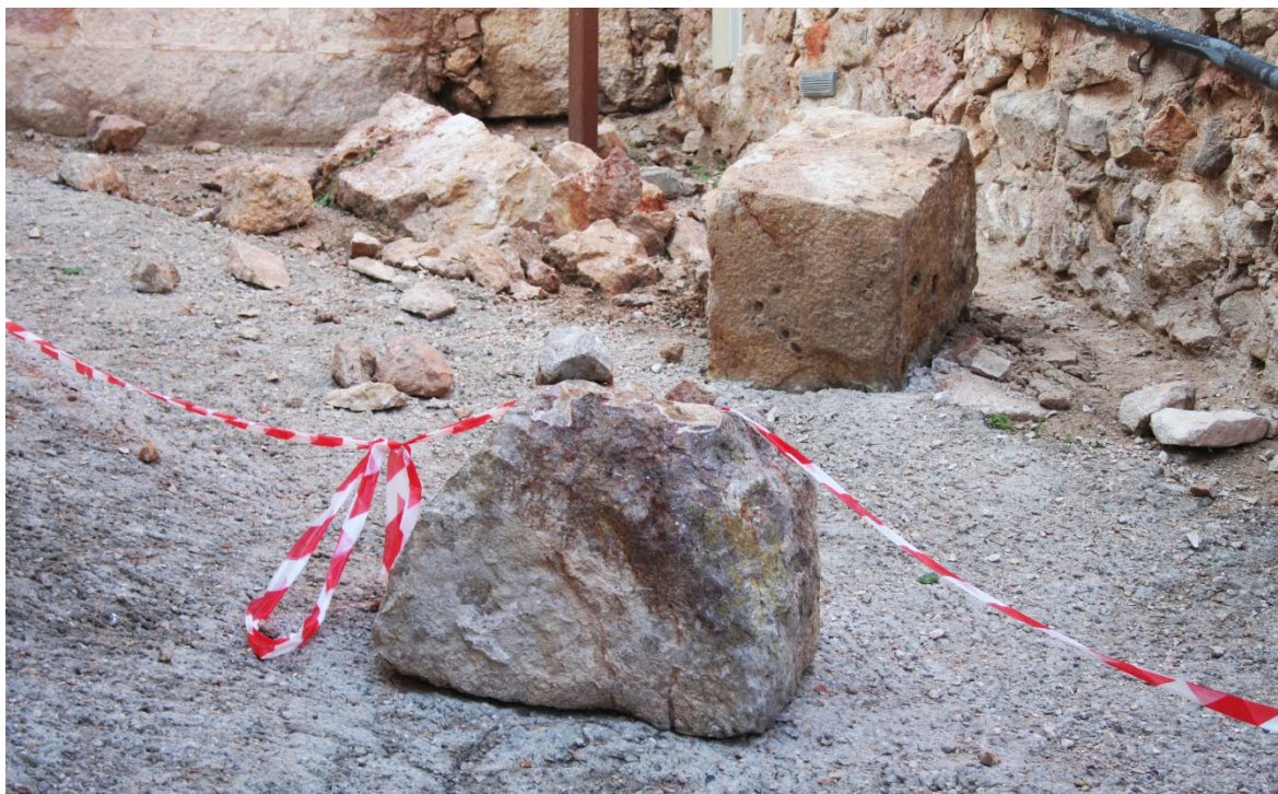
Fig. 3. Episodio de desprendimiento de grandes sillares de la torre del tesoro sobre el acceso al monumento, que a finales del 2008 obligó a cerrarlo al público durante un período de tiempo.
