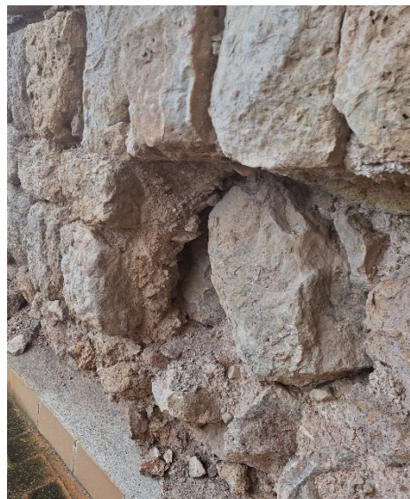
Fig. 4 y 5. Zonas de la parte superior incompleta de la torre del tesoro, actualmente apeadas provisionalmente con pilares de fábrica de ladrillo; y detalle de degradación con pérdidas volumétricas importantes existentes actualmente, en la base de muros interiores de la misma torre.
