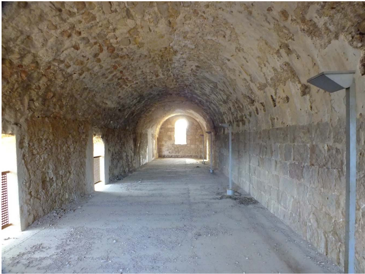
Foto 19. Estado actual del interior de la sala del comendador que se pretende adecuar en la presente actuación.
