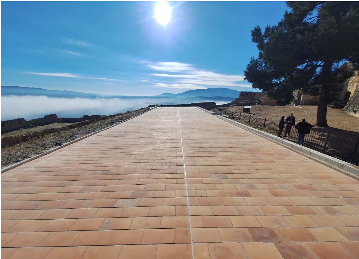
Foto 4. Aspecto de la cubrición implantada recientemente en las caballerizas, después de reconstruir la parte perdida de su bóveda.
