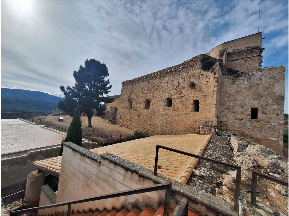
Foto 13. Vista de los restos de la misma torre en la que se aprecia su relación con la nave del refectorio situado a su izquierda y con la terraza que la cubre.
