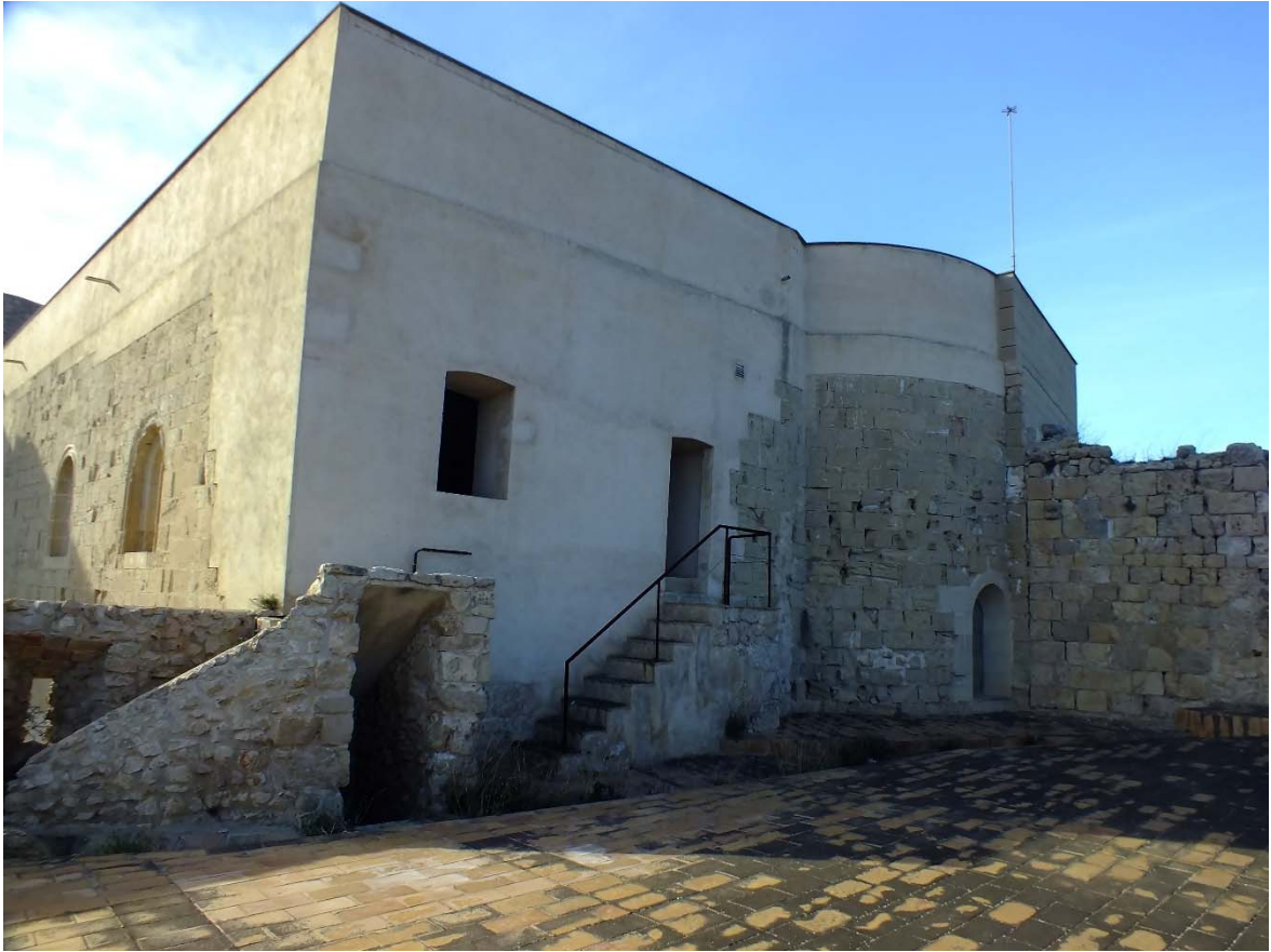
Foto 17. Vista del acceso a la sala del comendador desde la terraza situada sobre el refectorio. A la derecha, más allá del volumen curvo del ábside de la capilla, restos del cerramiento sur de la torre del tesoro.
