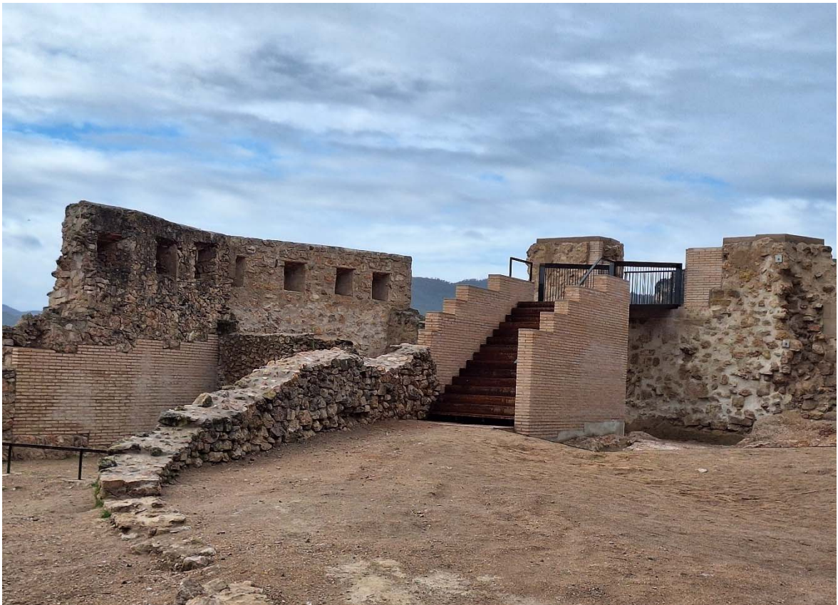
Foto 10. Acceso habilitado en el flanco oriental del bastión, recuperando en parte la morfología correspondiente a los inicios del s. XVIII, ejecutado en la misma actuación reciente.
