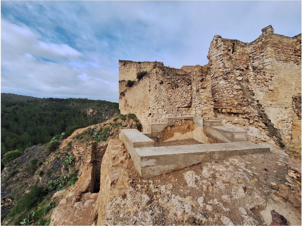
Foto 11. Vista de los restos interiores del bastión vistos desde el acceso mostrado en la imagen anterior.
