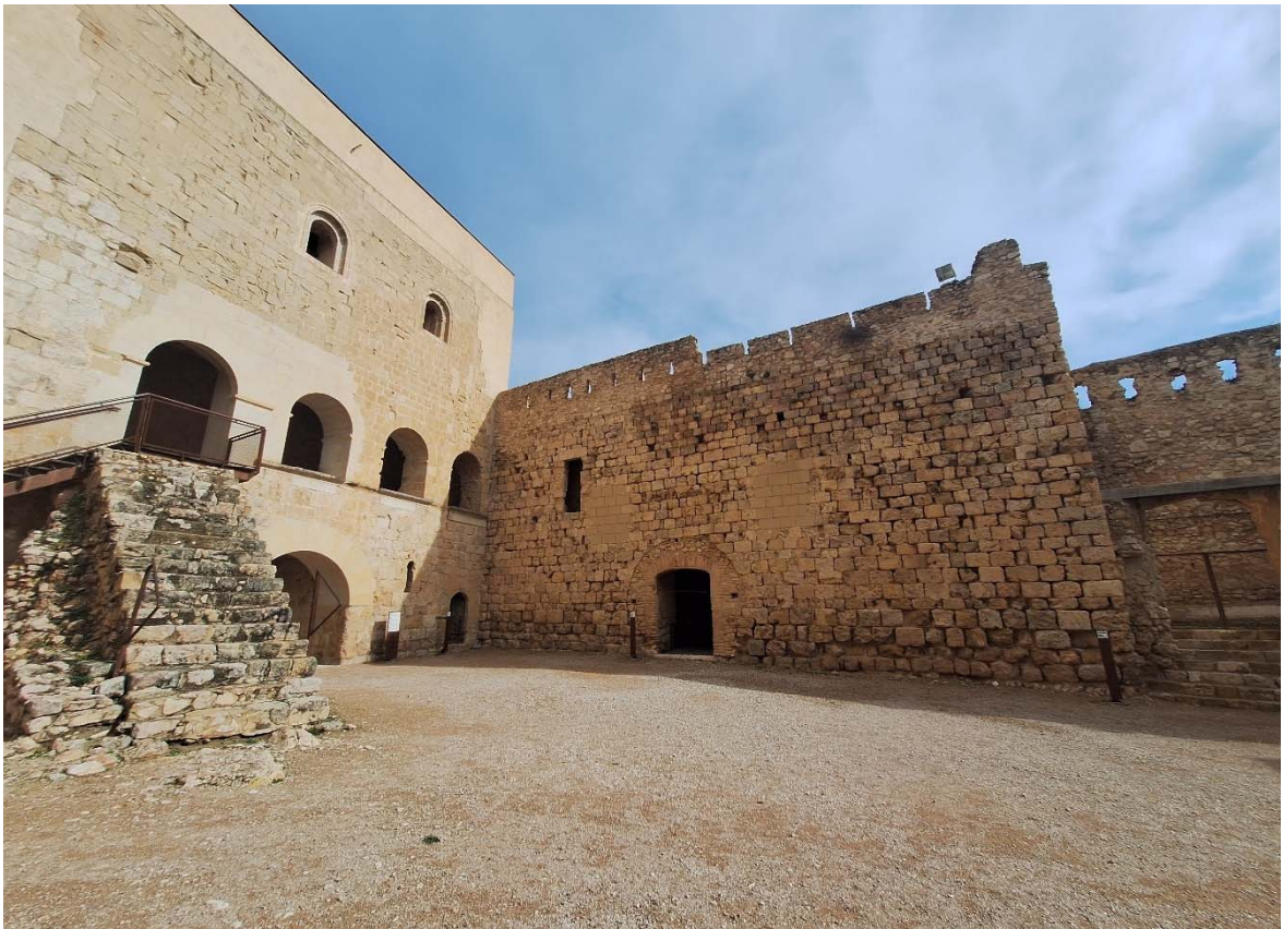
Foto 14. Vista del ángulo noreste del patio en el que, una antigua galería de madera desaparecida permitía el acceso a la terraza del refectorio desde la galería del profundis aneja a la capilla principal del castillo.
