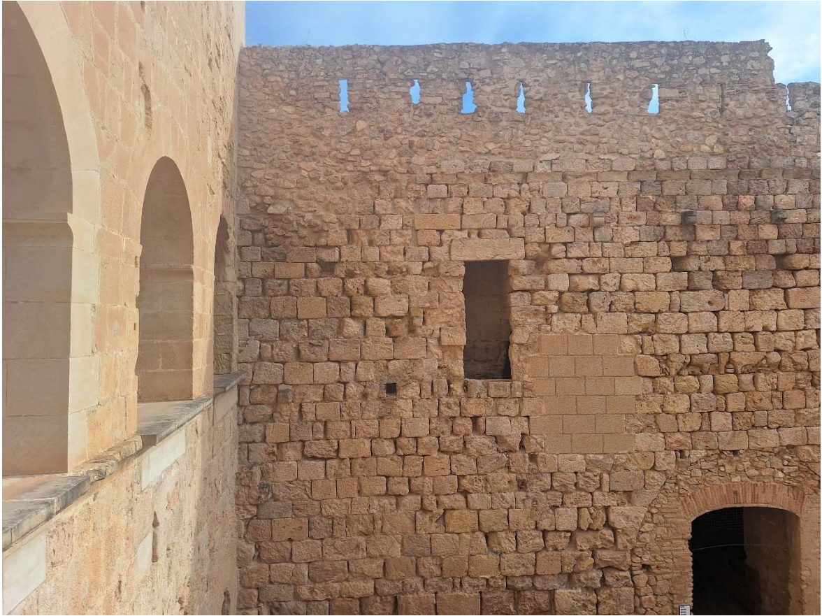
Foto 15. Detalle de la puerta actualmente inaccesible que, sobre el muro de cerramiento exterior del refectorio da acceso a su terraza a través de una escalera interior embebida en el muro.
