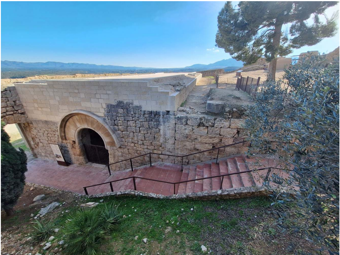
Foto 2. Detalle de la fachada norte de las caballerizas en la que recientemente se ha reconstruido su bella portalada y parte de su cerramiento.
