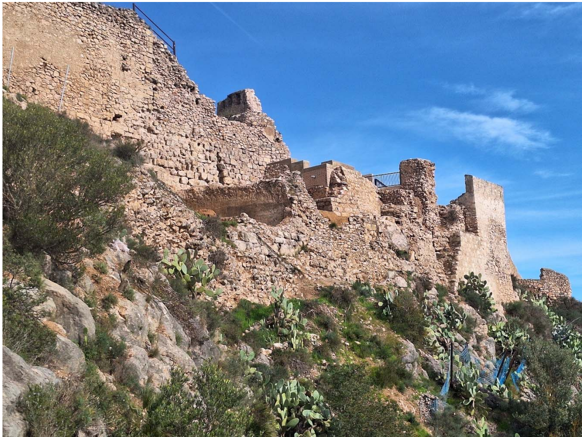
Foto 7. Vista exterior del ámbito del bastión de mediodía con las precarias estructuras puestas a luz después de la excavación arqueológica que ha eliminado su incoherente relleno de tierras y escombros.
