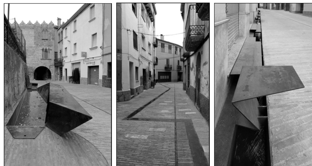
Figura 2. Fotografies de les obres executades a la fase primera de les actuacions al nucli antic
