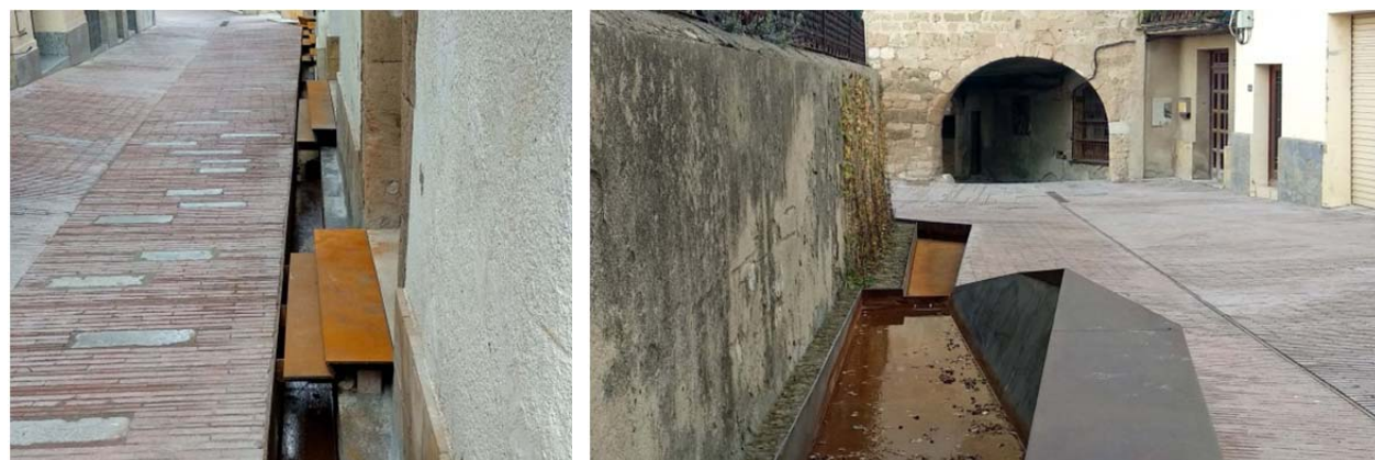
Figura 3. Fotografies dels paviments i dels recs executats al carrer Major.
