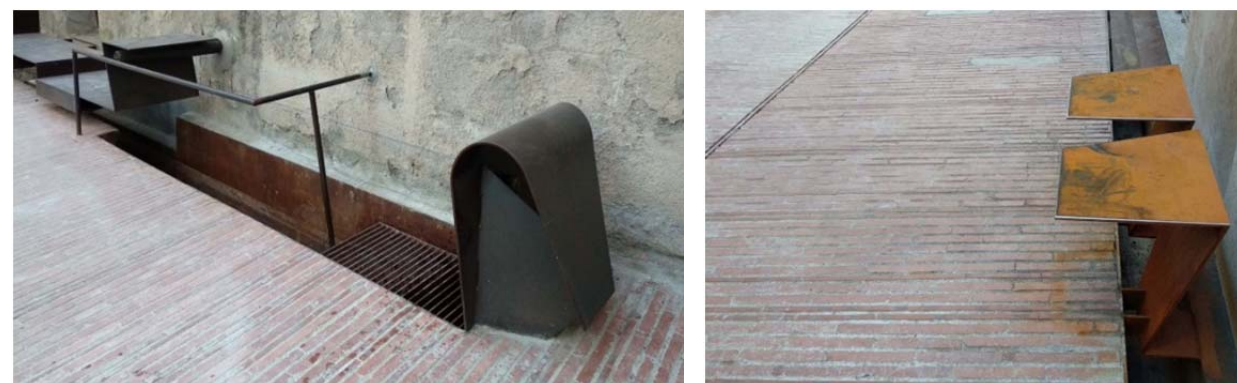
Figura 4. Paviments i mobiliari executats a la zona de l'Abeurador i al carrer Major.
