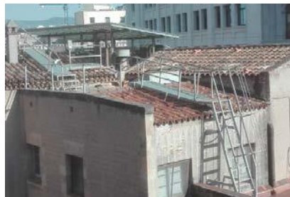
Foto sistema de passarel·la
