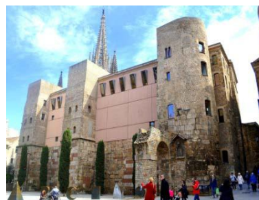
Façana Plaça Nova
