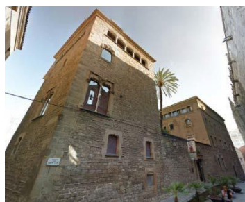
Façana Carrer Santa Llúcia
