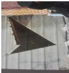
Accés a coberta
