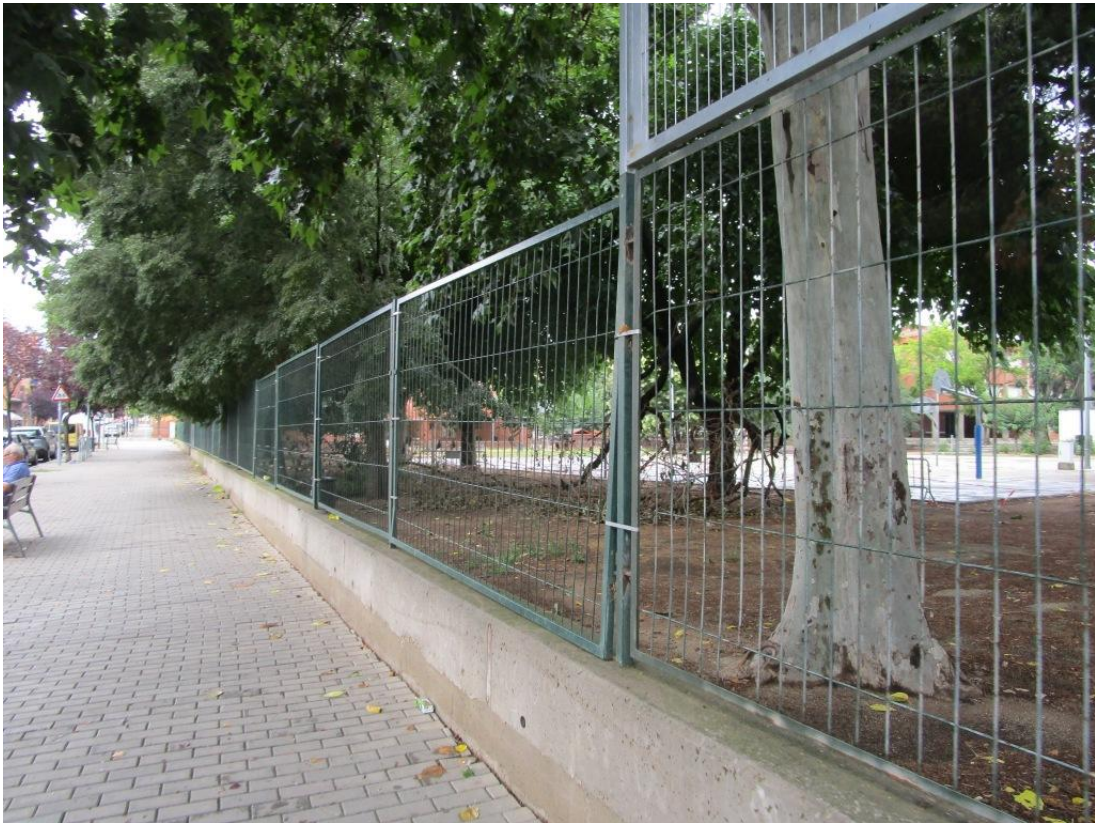
Tanca carrer Verge del Pilar
