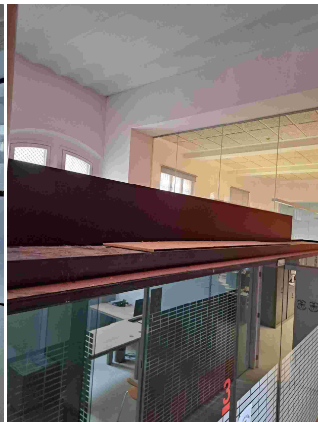
F7.- Exterior doble sostre
