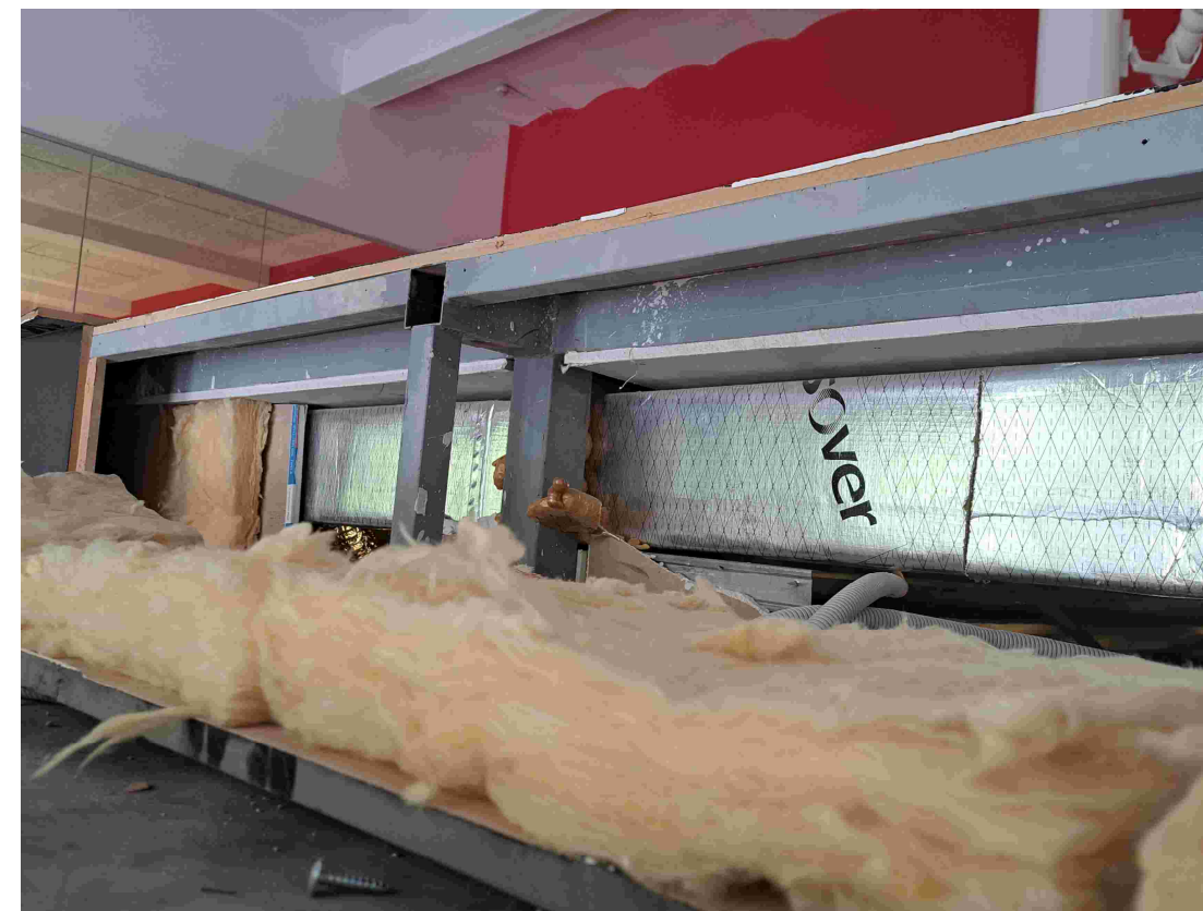
F9.- Doble sostre . Costat pas posterior
