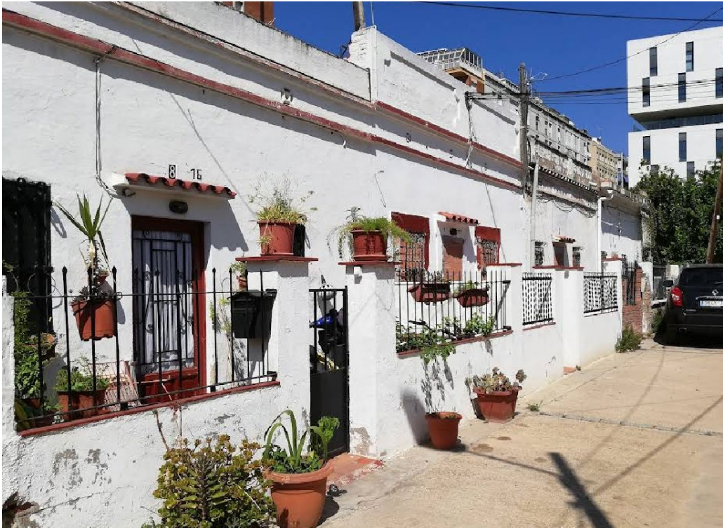
Vista de les façanes des del passatge de Piera
