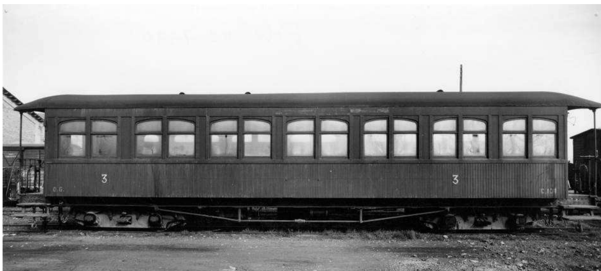
Cotxe num CGFC C 101 en estat original de fusta a Martorell Central anys 70
