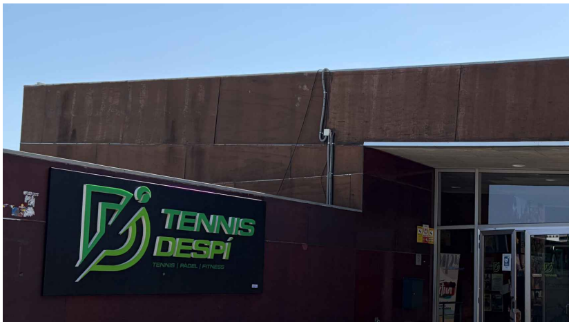
FAÇANA EST (ACCÉS PRINCIPAL) - RENOVACIÓ DE L'ACABAT DELS PANELLS
