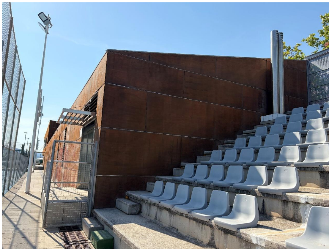
Façana costat grades
