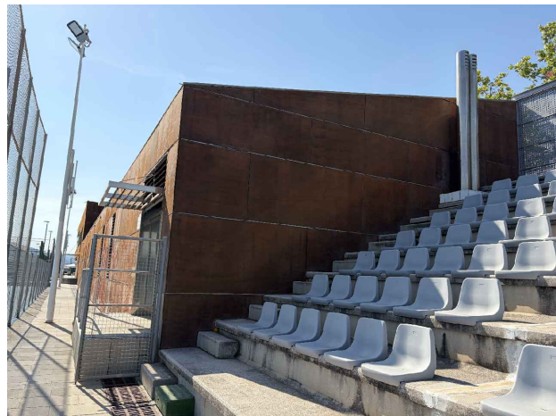
FAÇANA EST (COSTAT GRADES) - RENOVACIÓ DE L'ACABAT DELS PANELLS
