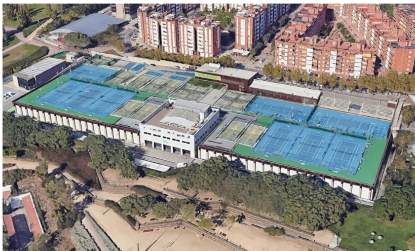
Emplaçament Tennis Despí
