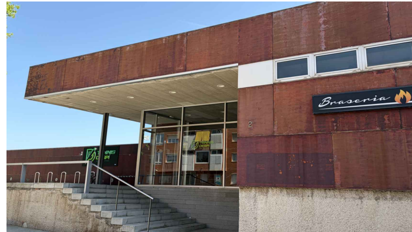
FAÇANA NORD - RENOVACIÓ DE L'ACABAT DELS PANELLS I REPARACIONS PUNTUALS
