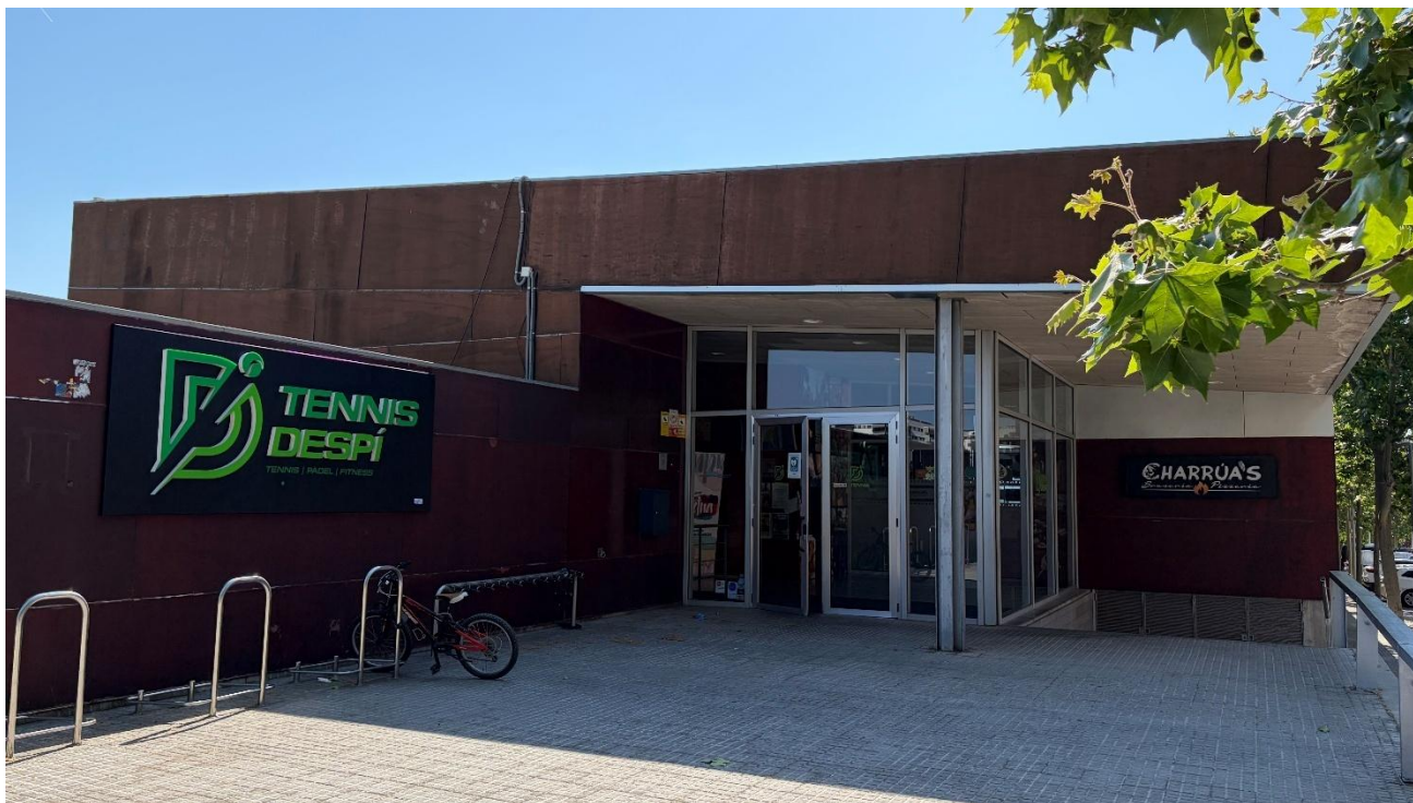
Façana accés instal·lacions
