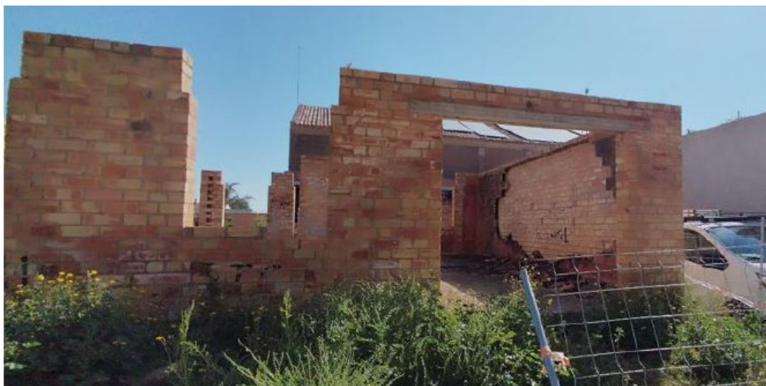
Imatge de la construcció
