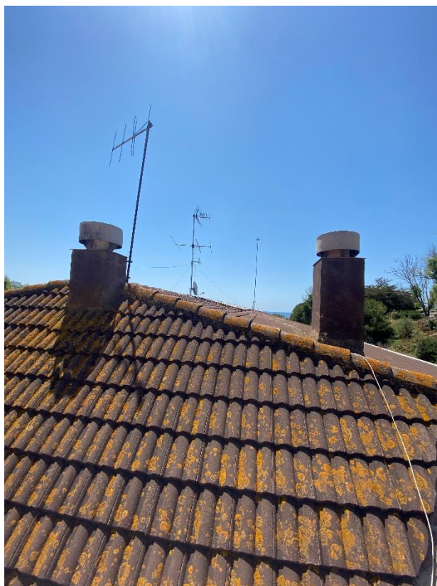
Fotografia 2. Coberta 2 objecte de la instal·lació
