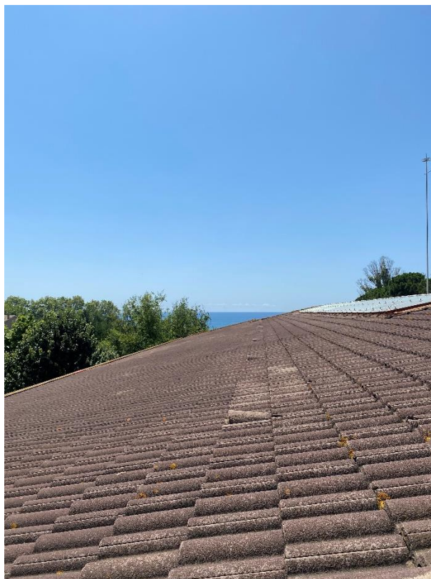
Fotografia 1. Coberta 1 objecte de la instal·lació
