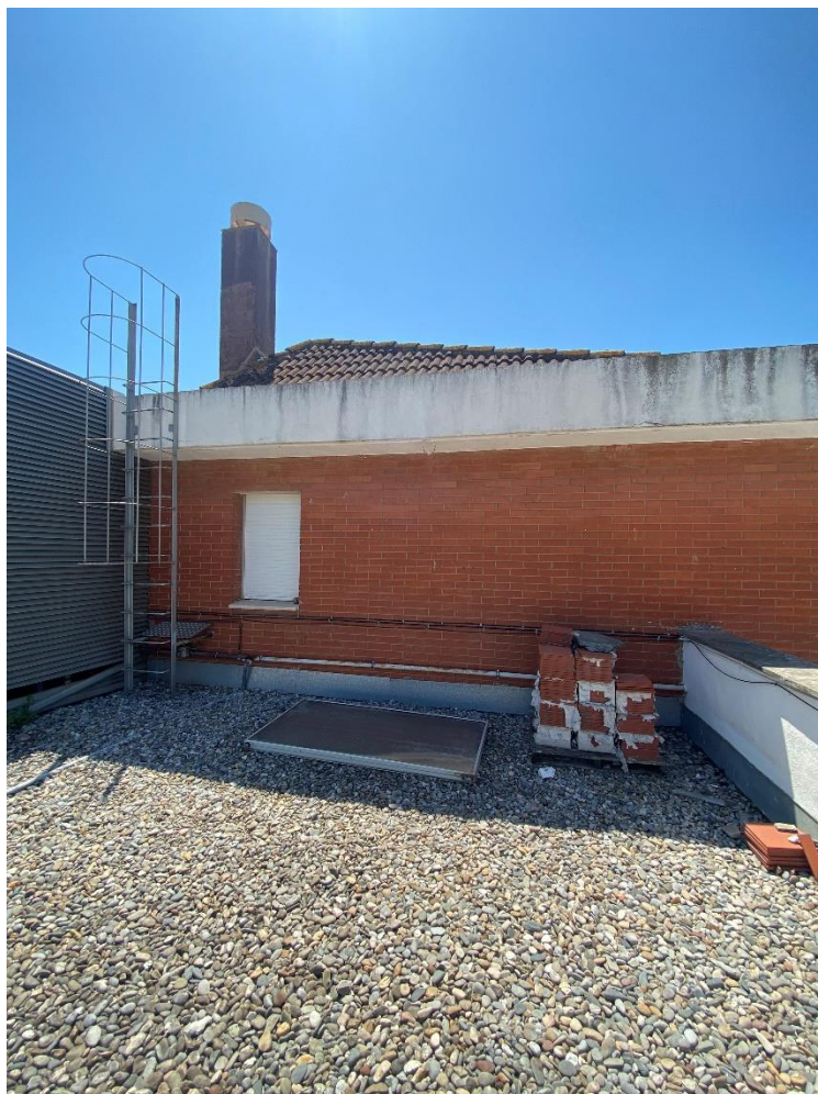
Fotografia 7. Fotografia escala de gat per accés a la coberta
