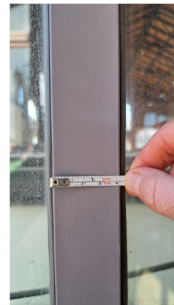
DETALL JANISOL ARTE DE JANSEN INSTAL·LADA A LA FAÇANA NORD
