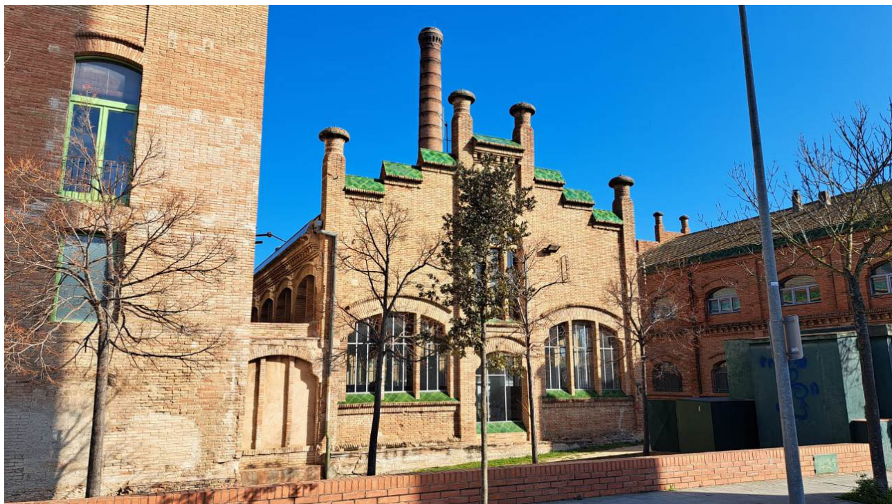
Façana sud de la nau del bar del Centre Cultural
