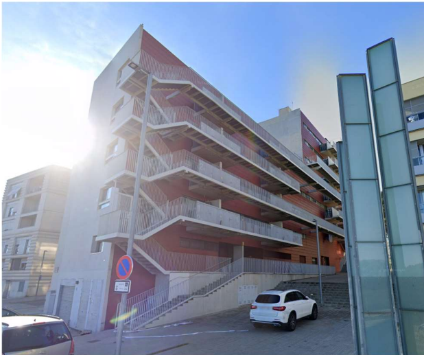
Figura 3. Façana nord bloc G
