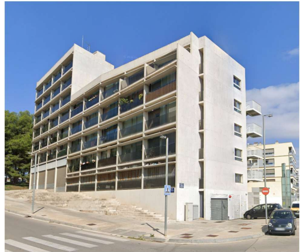
Figura 4. Façana sud bloc G
