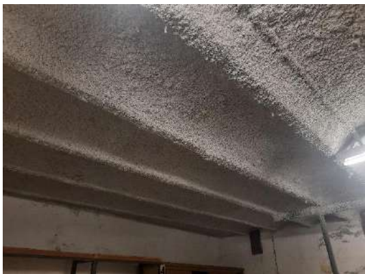
Sostre de la pl. soterrani, ignifugat (sala 1)
