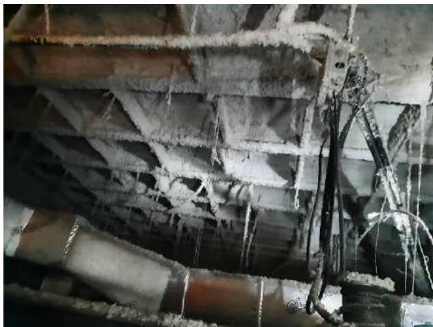
Sostre de la pl. baixa, ignifugat
