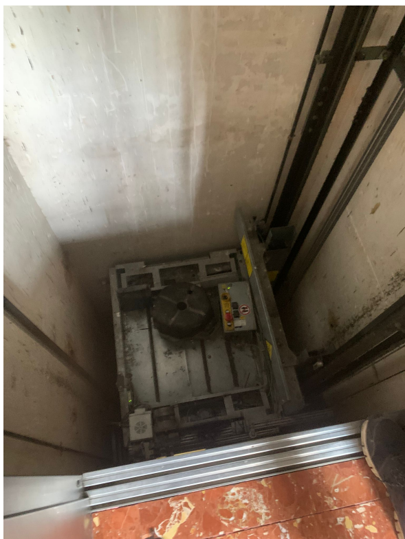
Detall del buc de l'ascensor
