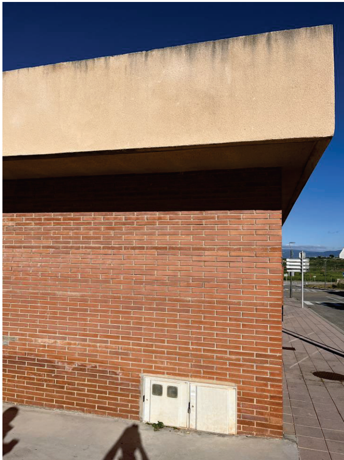
Lateral nord façana est. Caixes existents.
