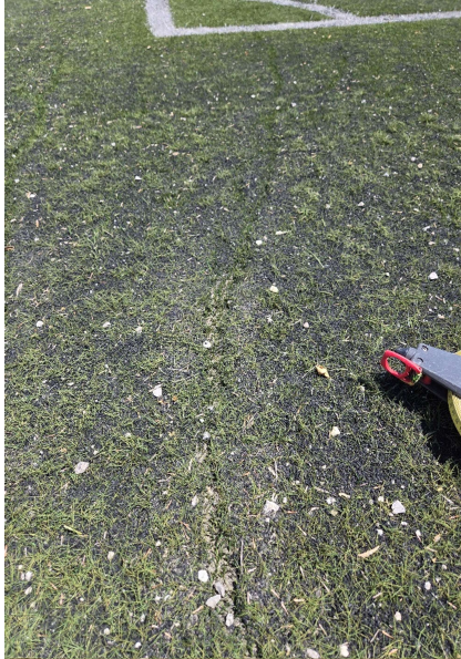
Foto 5. Trencament i desgast total dels filaments.
