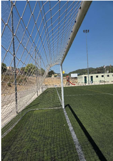
Foto 9. Desmuntatge de porteries, repàs, sanejat i pintat, i posterior muntatge.
