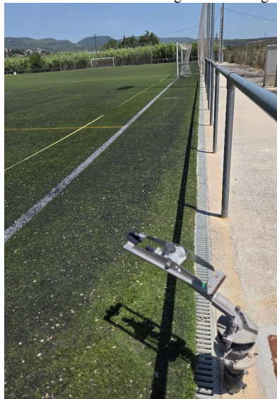
Foto 7. Aspersors de baixa alçada i sense protecció. Es procedirà a la seva substitució.
