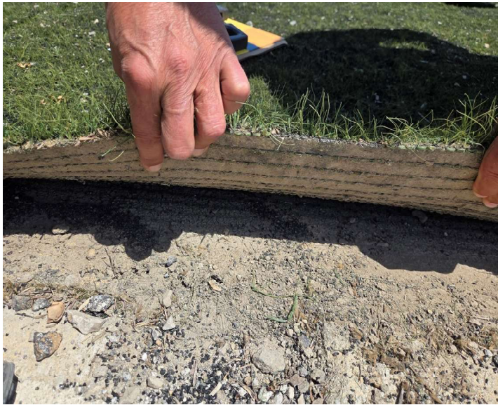
Foto 4. Assentament sobre capa asfàltica i en perímetre en paviment de formigó.
