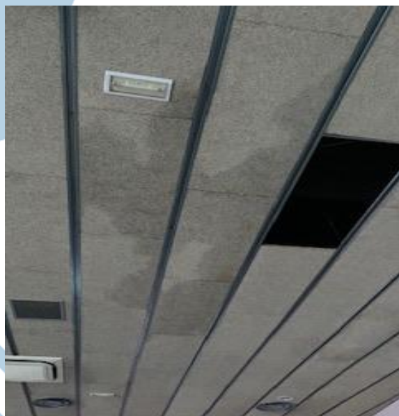
Imatge 5. Humitats en les plaques del sostre. Font: Elaboració pròpia.
