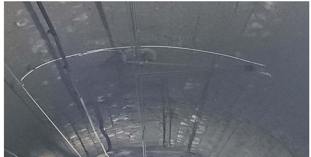
Fotografia 6 - Túnel de la Bauma. Recta, Ca8T, Ca4-2T volta gàlib reduït.
