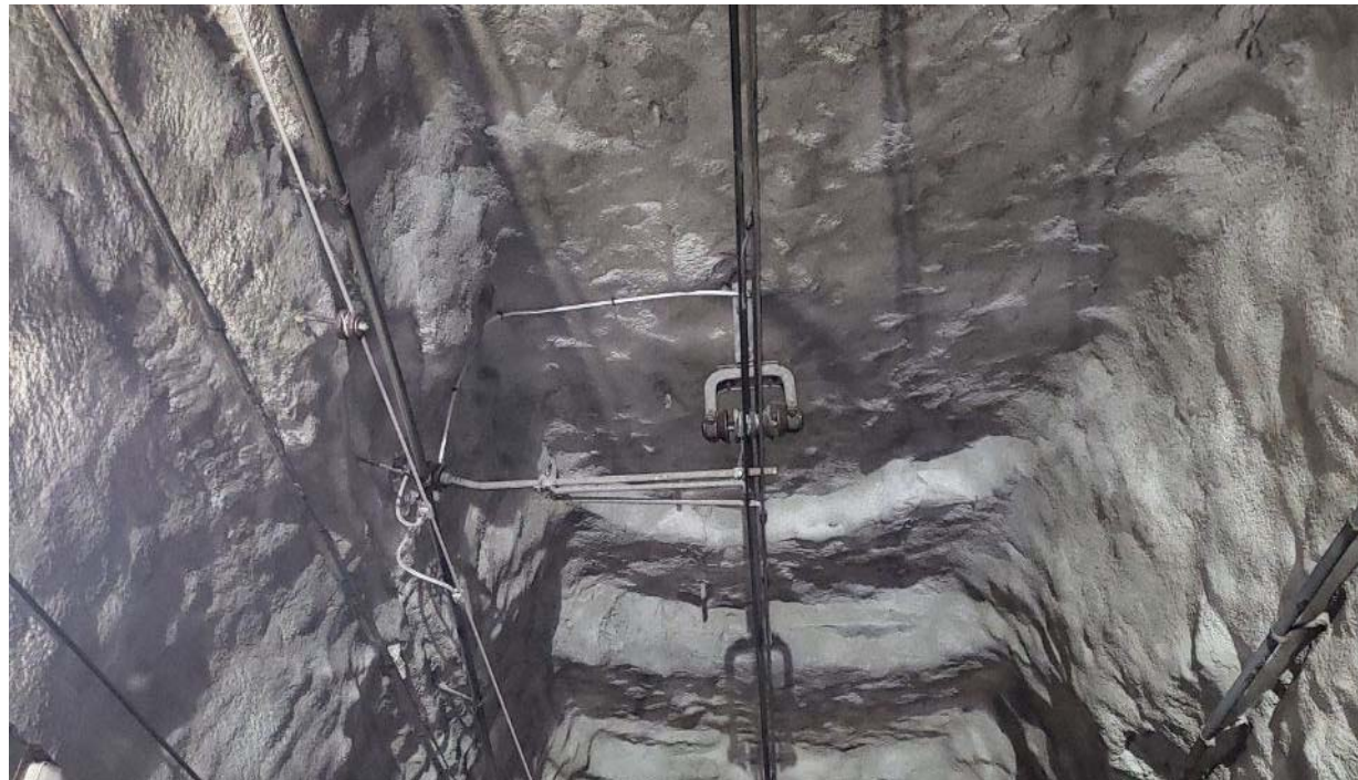
Fotografia 23 – Túnel de Firmat. Corba, Ca28T,Ca2-2T
