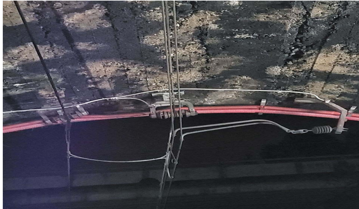
Fotografia 1 – Túnel de la Bauma. Corba, Ca27T, Ca4-1T, Ca2-1T boca túnel costat Martorell.
