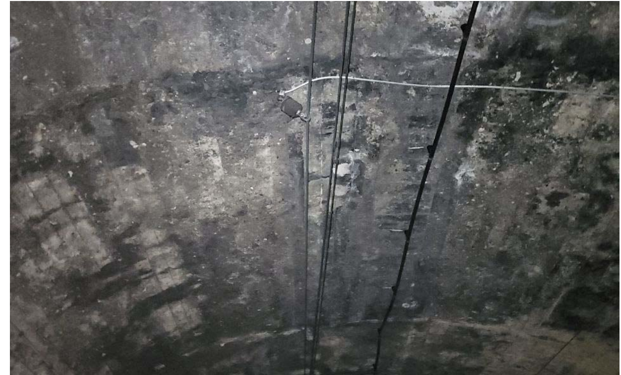
Fotografia 14 – Túnel de la Bauma. Suspensió de feeder centre vano Ca9-3
