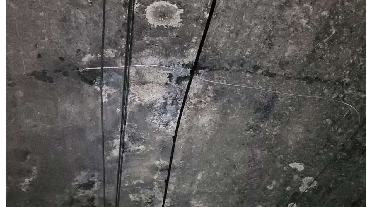
Fotografia 16 – Túnel de la Bauma. Suspensió de feeder centre vano Ca9-3.
