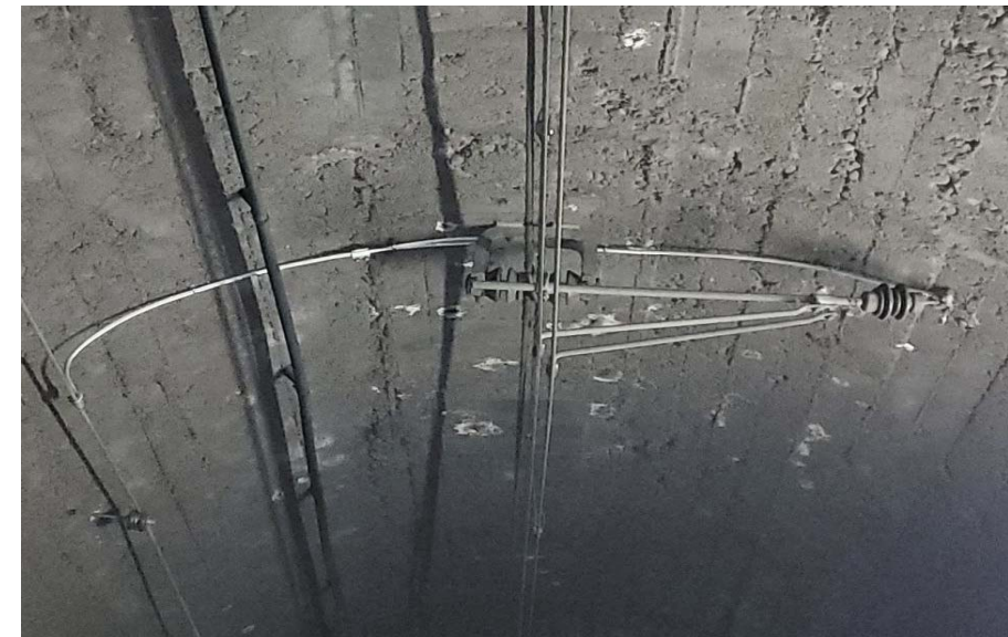
Imatge 6 – Túnel de La Bauma. Recta, Ca8T, Ca4-2T volta gàlib reduït.
