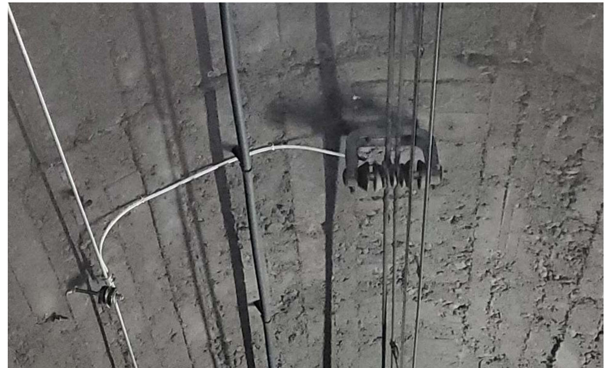
Fotografia 8 - Túnel de la Bauma Recta, sense atirantat, Ca4-2T, volta gàlib reduït.
