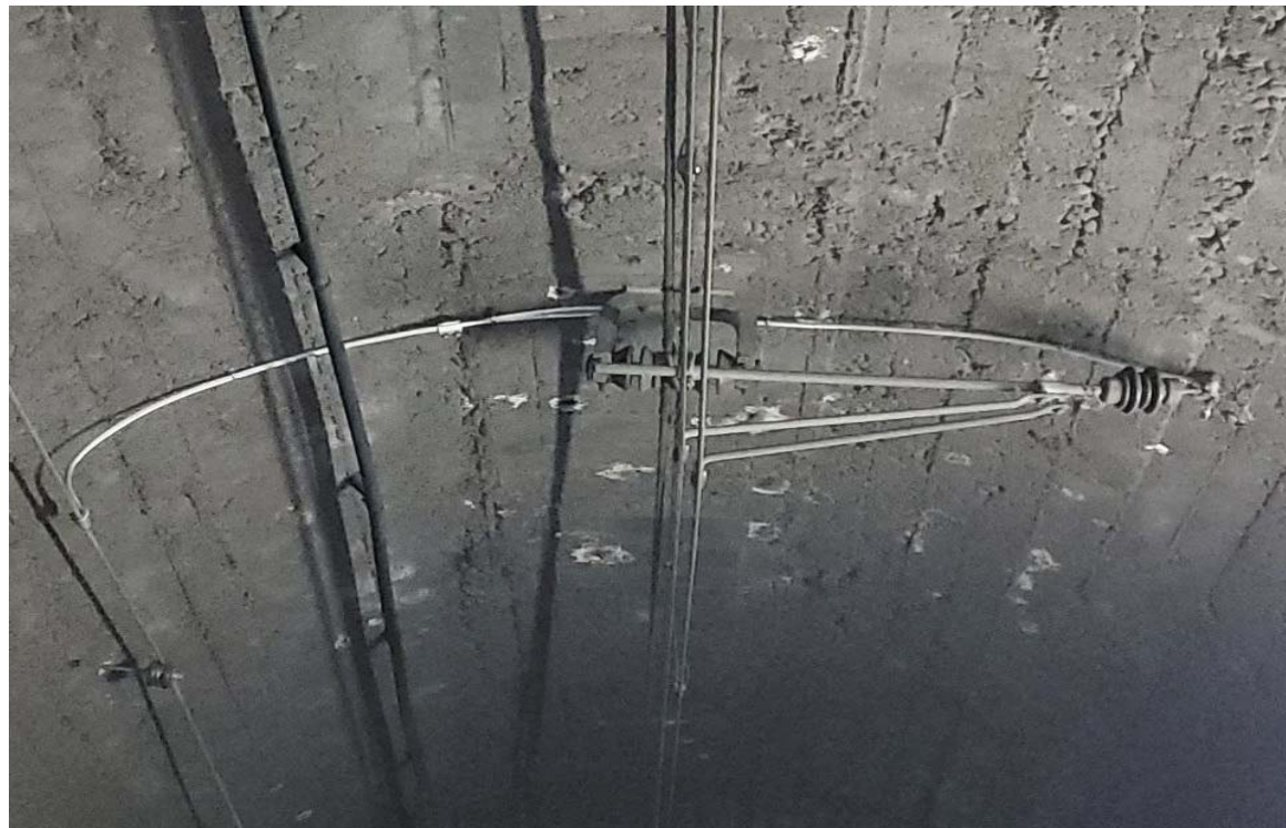
Fotografia 7 - Túnel de la Bauma. Recta, Ca8T,Ca4-2T volta gàlib reduït.
