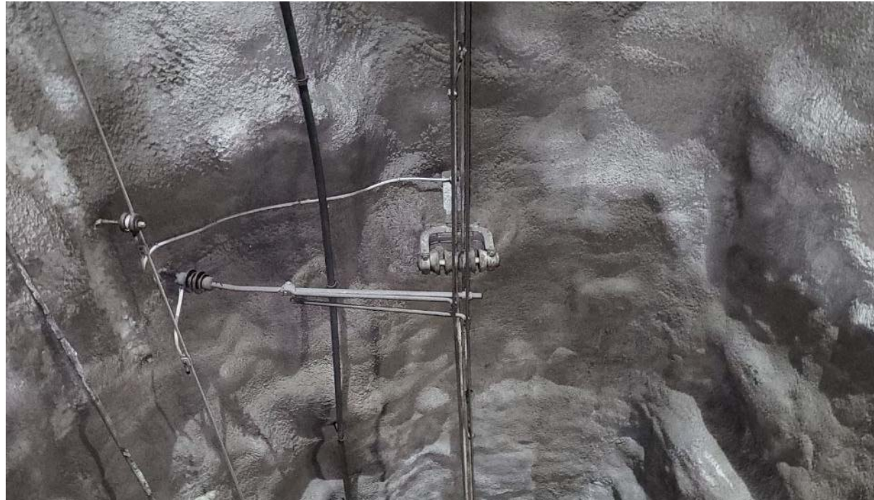
Fotografia 21 – Túnel de Firmat. Recta, Ca8T, Ca4-2T, volta gunitada
