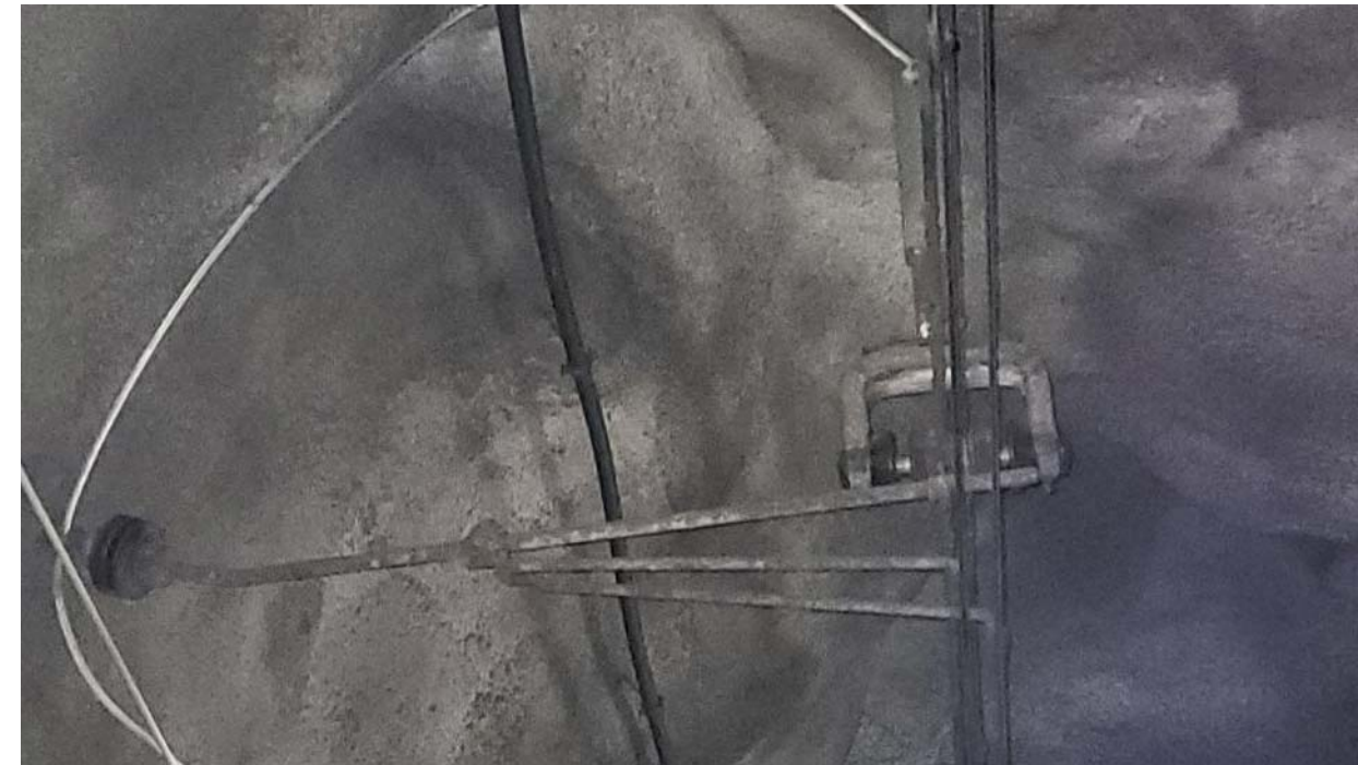
Fotografia 10 – Túnel de la Bauma. Recta, Ca8T, Ca4-2T, volta gunitada
