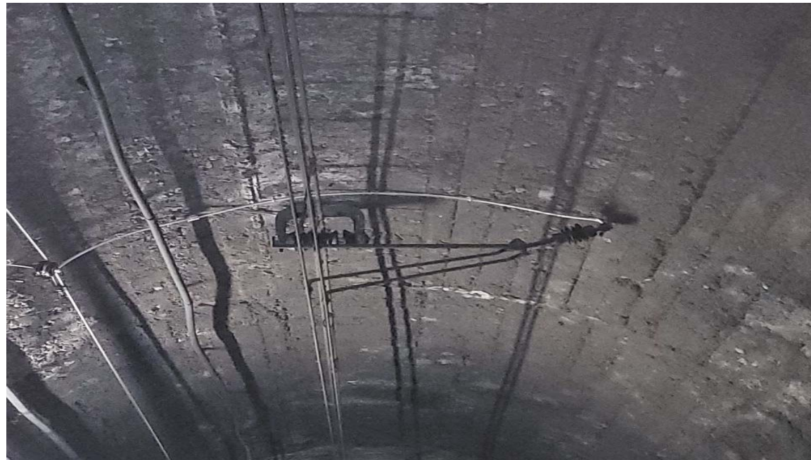
Fotografia 5 - Túnel de la Bauma. Recta, Ca8T,Ca4-2T volta gàlib reduït.
