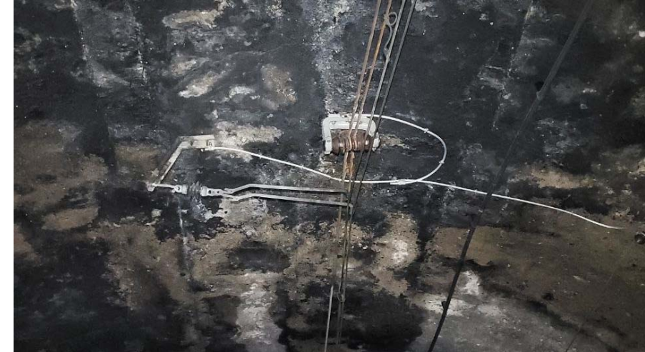
Imatge 5 – Túnel de Castellbell. Corba, Ca27T,Ca2-2T
