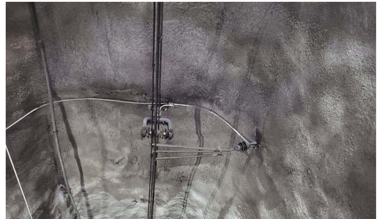
Fotografia 20 – Túnel de Firmat. Recta, Ca8T, Ca4-2T, volta gunitada.
