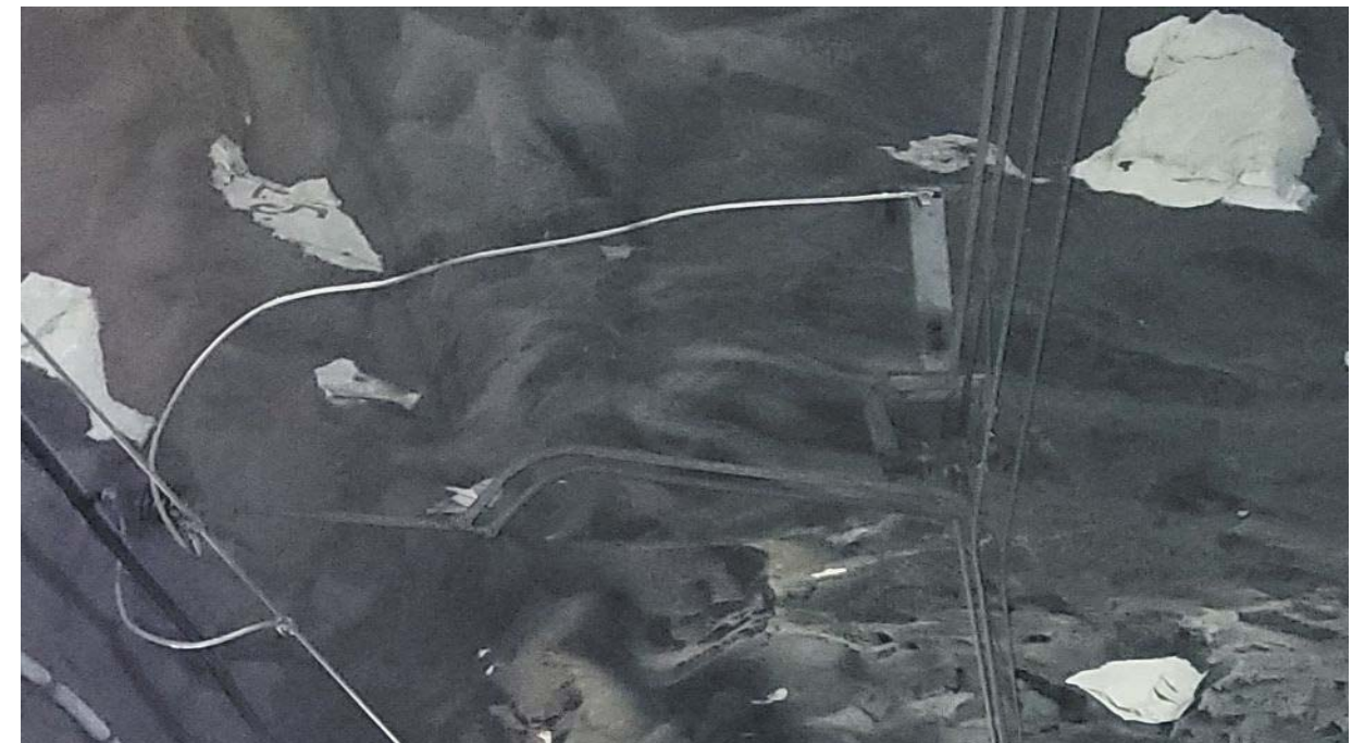
Fotografia 4 – Túnel de la Bauma. Corba, Ca28T, braços F11, Ca2-2T.
