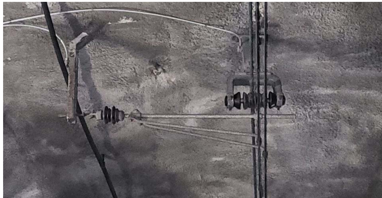
Fotografia 11- Túnel de la Bauma. Recta, Ca7T, Ca4-2T, volta gunitada
