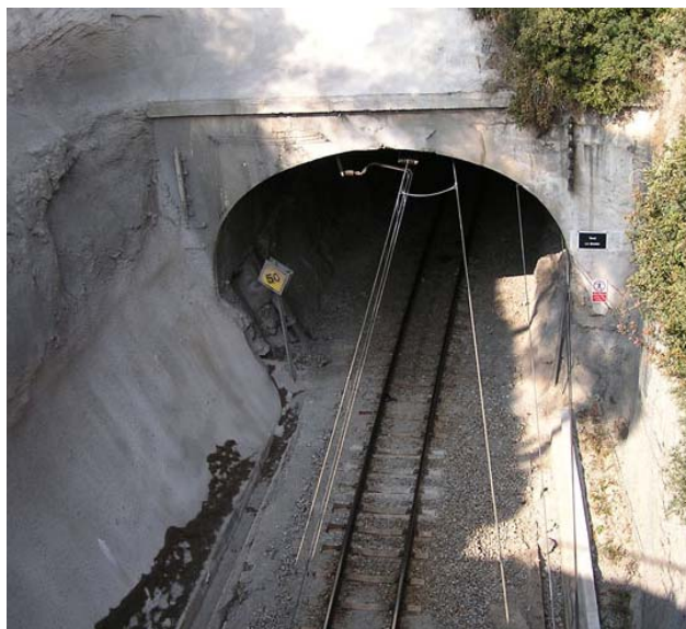
Imatge 1 – Boca Sud túnel de La Bauma PK 47/252
