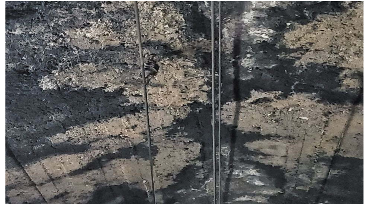
Fotografia 2 – Túnel de la Bauma. Suspensió de feeder centre vano Ca9-3.
