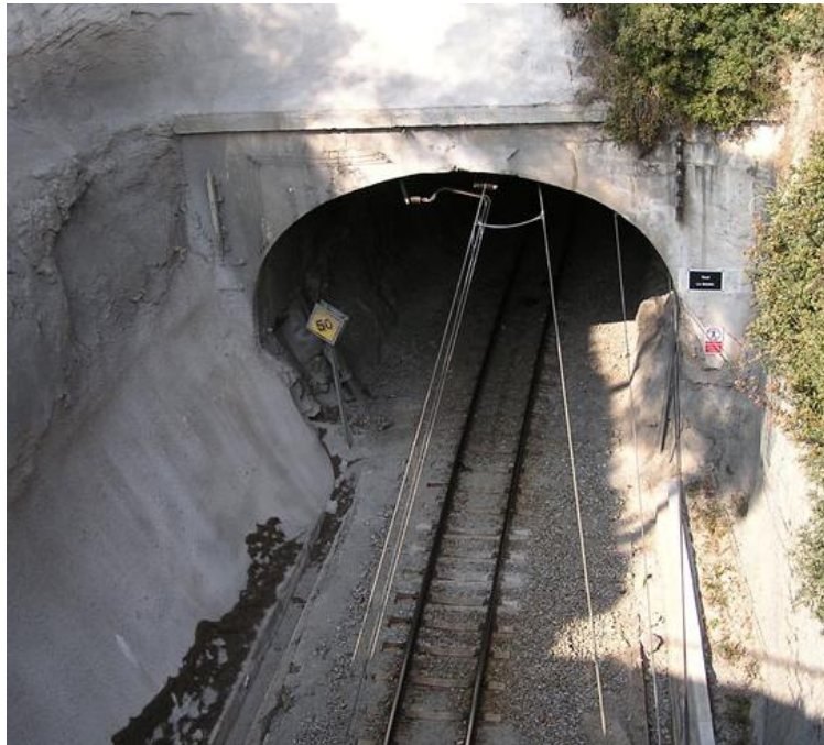
Imatge 5 - Boca sud túnel de La Bauma
