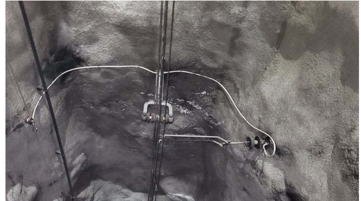
Fotografia 22 – Túnel de Firmat. Corba, Ca28T, Ca2-2T.
