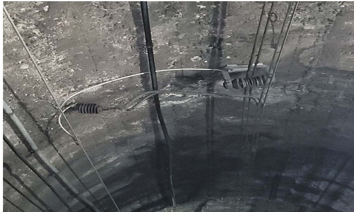
Fotografia 3 – Túnel de la Bauma. Corba, Ca28T, Ca2-2T.
