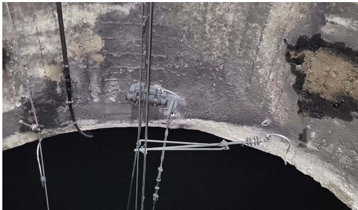
Fotografia 19 – Túnel de Firmat. Recta, Ca8T, Ca4-2T, boca túnel costat Martorell
