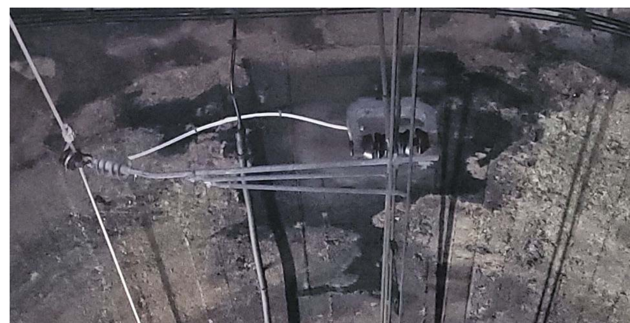
Fotografia 12 – Túnel de la Bauma. Recta, Ca8T, Ca4-2T, boca túnel costat Manresa.
