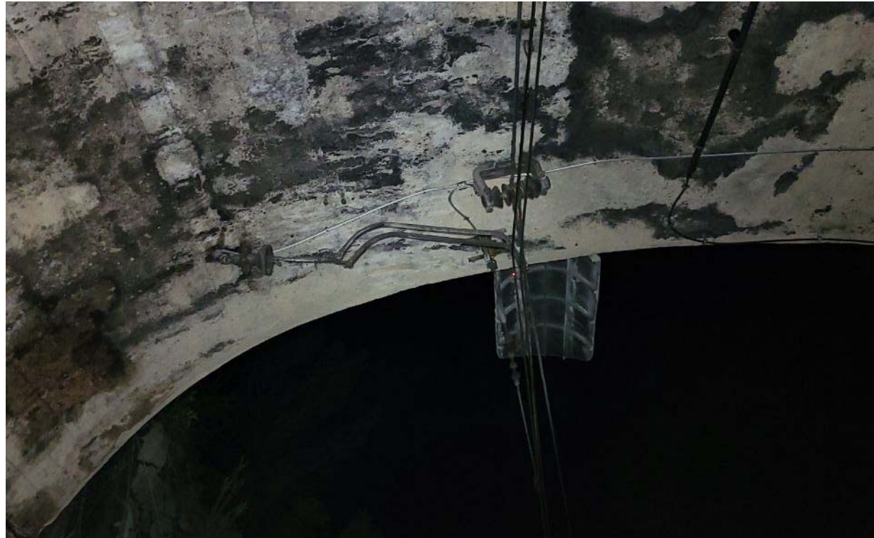
Fotografia 13 – Túnel de Castellbell. Corba, Ca28T, Ca2-2T, boca túnel costat Martorell
