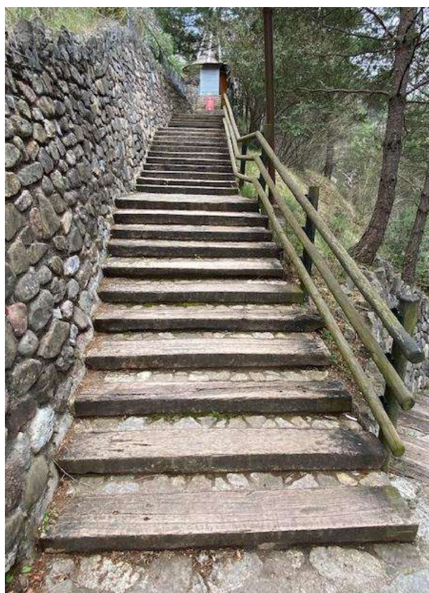
Escala d'accés de pedra
