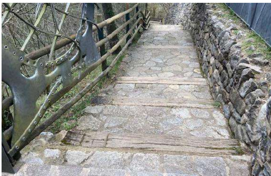
Escales d'accés de pedra
