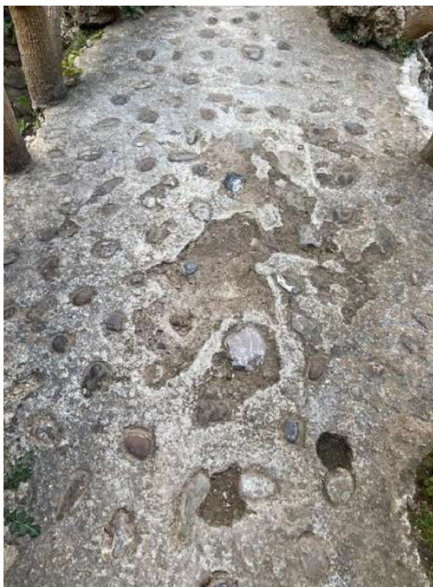
Paviment actual Pont dels Arcs
