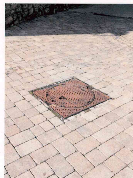
DETALL PAVIMENT TROBADA LLAMBORDA I INSTAL·LACIONS
