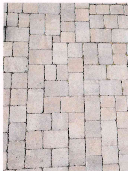
DETALL PAVIMENT TIPUS LLAMBORDA COL.LOCACIÓ ALEATÒRIA
