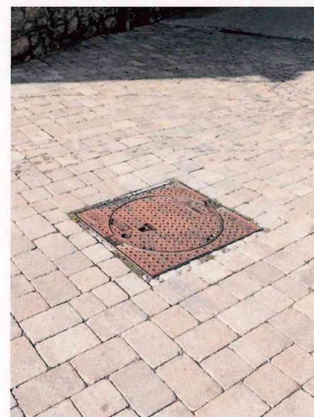
DETALL PAVIMENT TROBADA LLAMBORDA I INSTAL·LACIONS
