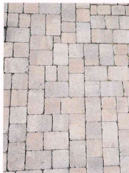
DETALL PAVIMENT TIPUS LLAMBORDA COL·LOCACIÓ ALEATÒRIA
