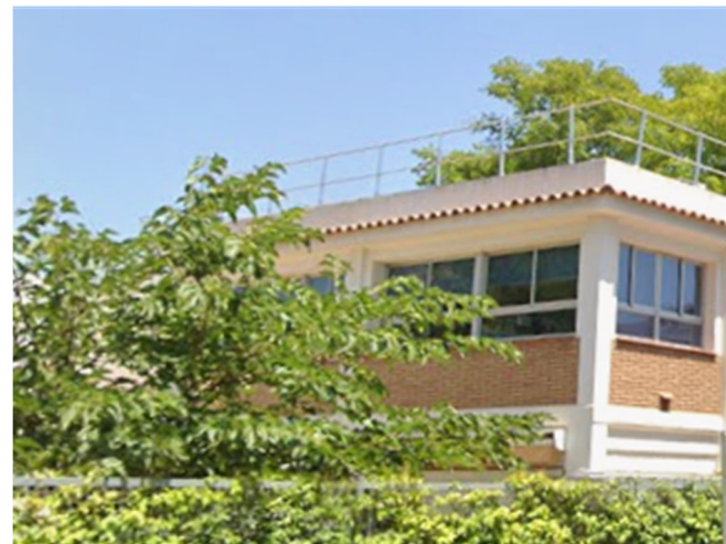
Façana est de l'escola bressol Sol Solet
