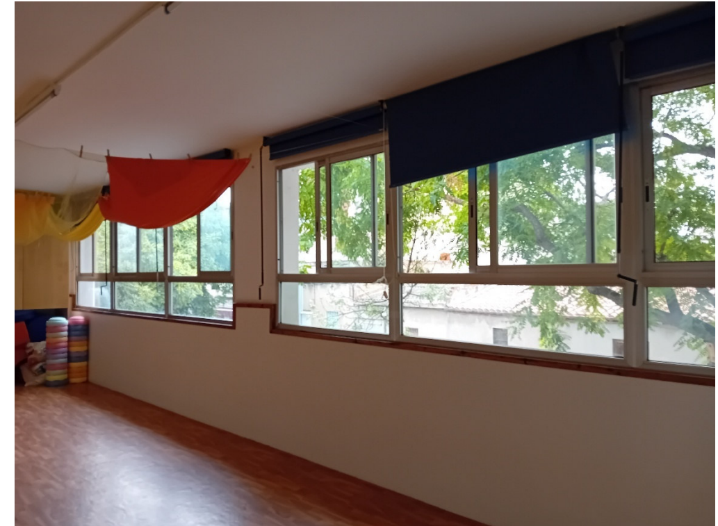
Vista interior finestres a les aules d'infantil a planta primera
