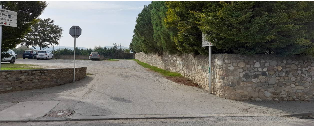
Foto 1: Vista de l'accés i sortida de la plaça al carrer Almeda situat més al Nord.
