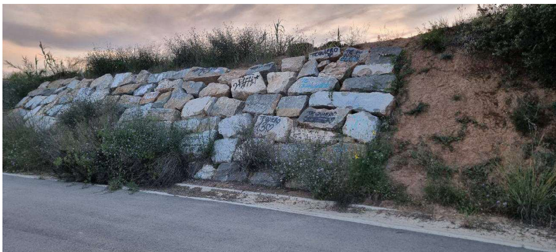
Mur de contenció
