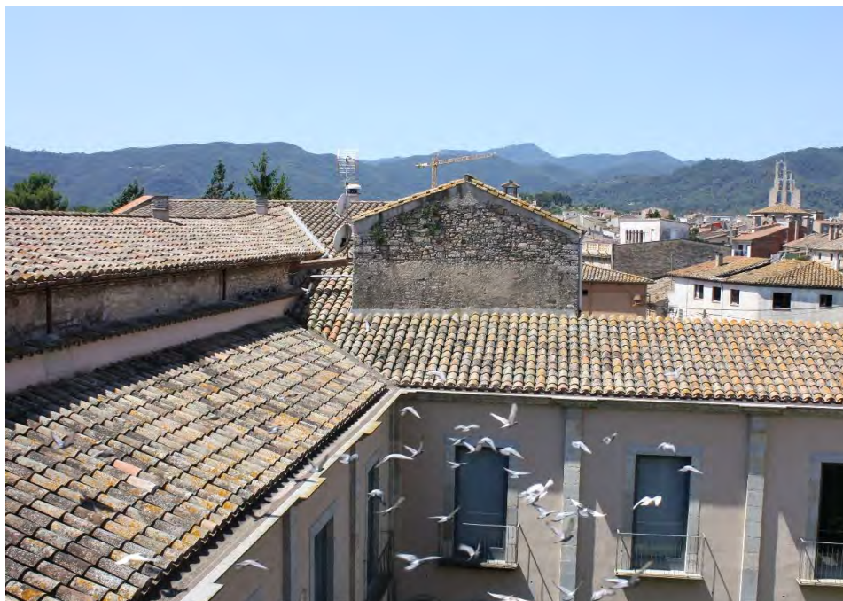
Canal interior cobertes del claustre
