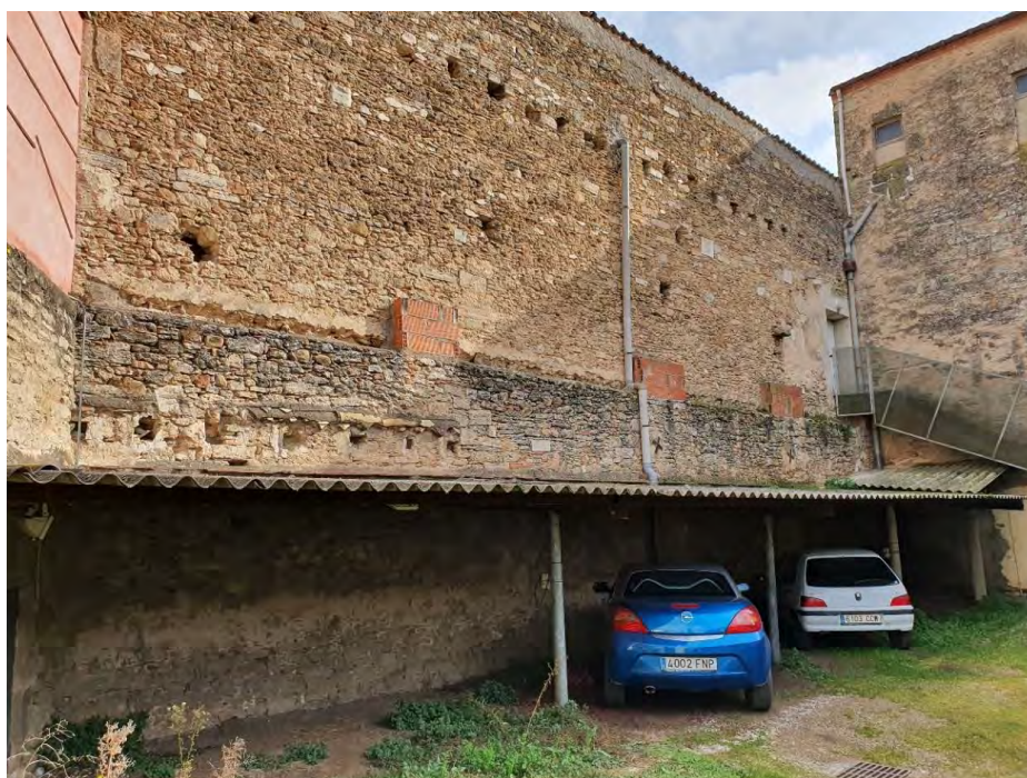
Mur posterior, façana sud
