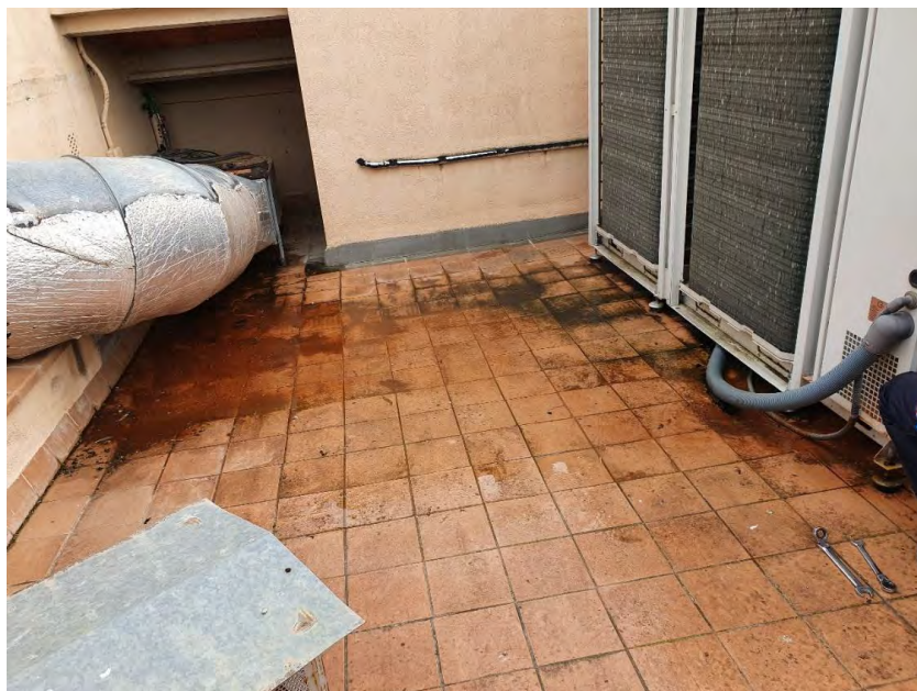
Coberta plana interior on s'ubicarà la unitat exterior del sistema de climatització
