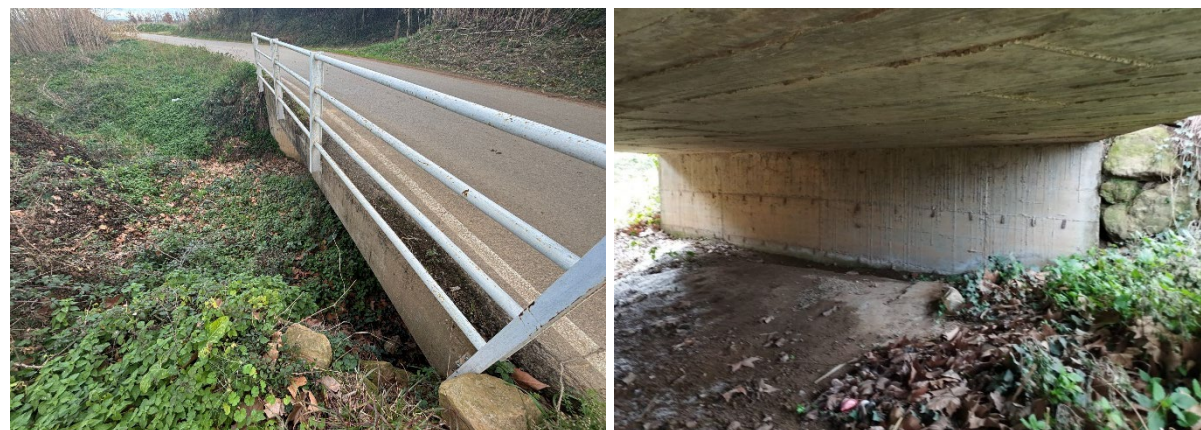
Figura 1. Torrent de Ploent aigua avall de l'estructura vista des del marge esquerre (esquerre) i estat actual de l'estructura del camí Fondo sobre el torrent de Ploent (dreta).
