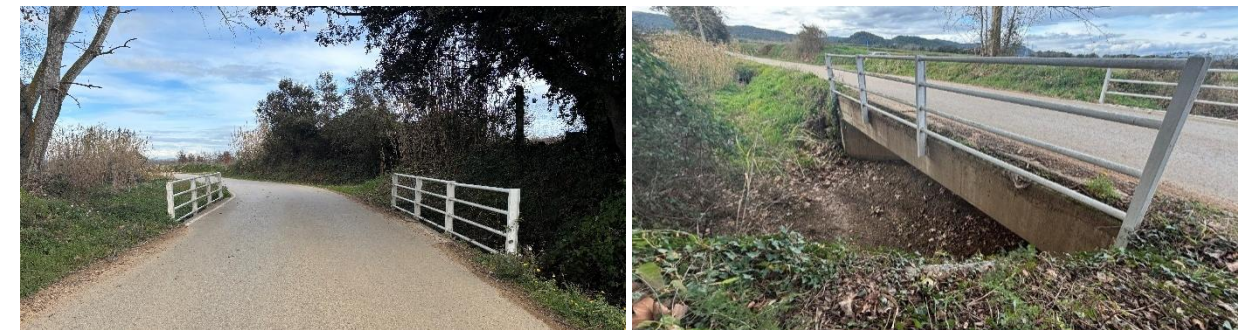
Figura 2. Vista de l'estat actual del pont del Barri de l'Estació.
