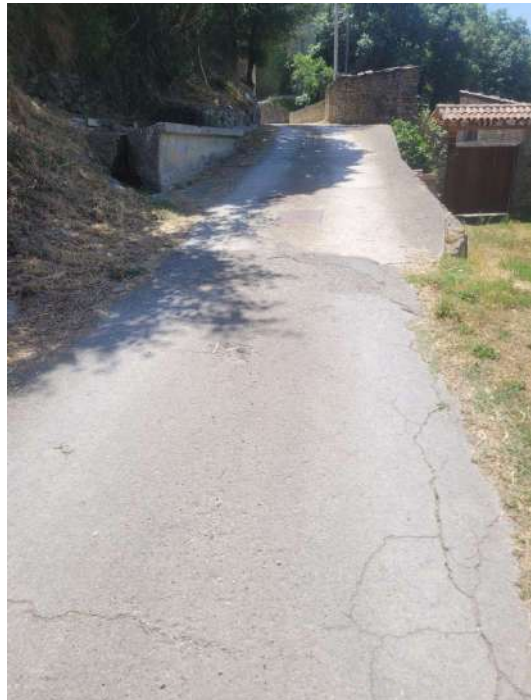
Eroles: Final tram pavimentat
