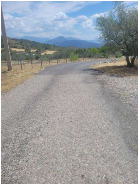
Sant Adrià: Punt inici pavimentat
