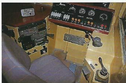
Taulell de conducció situat a la dreta de la cabina
