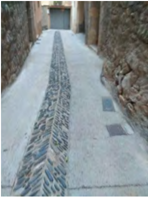
Paviment de còdols sobre base de formigó
