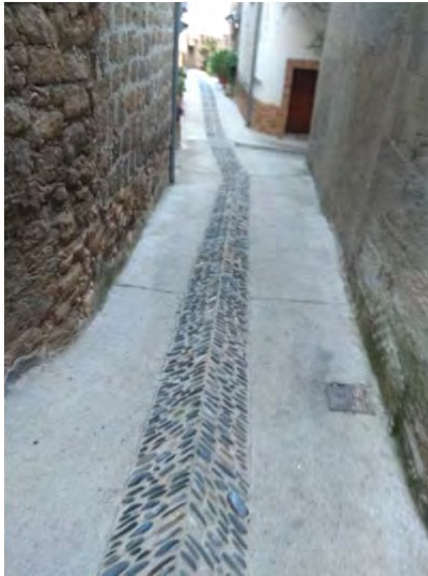
Imatge paviment existent
