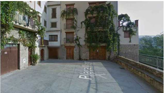
Paviment de formigó
