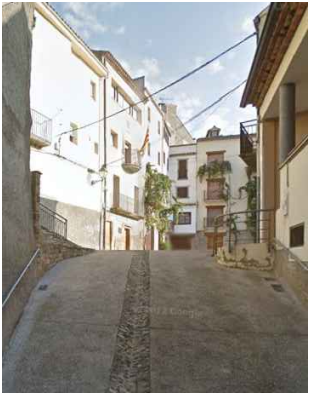
Paviment de còdols sobre base de formigó
